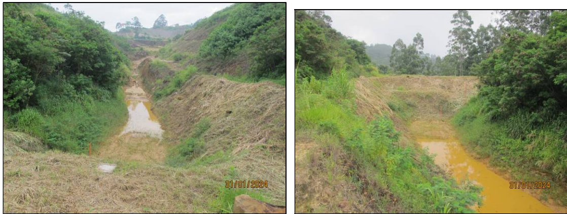
Figura 9.11- Vista do talude de montante e reservatório do dique D-03 – 31/01/2024.
