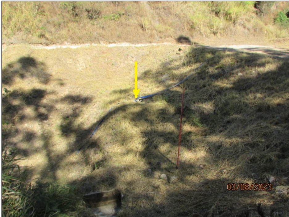
Figura 6.1- Posicionamento do conjunto de bombeamento sobre o talude de montante.
