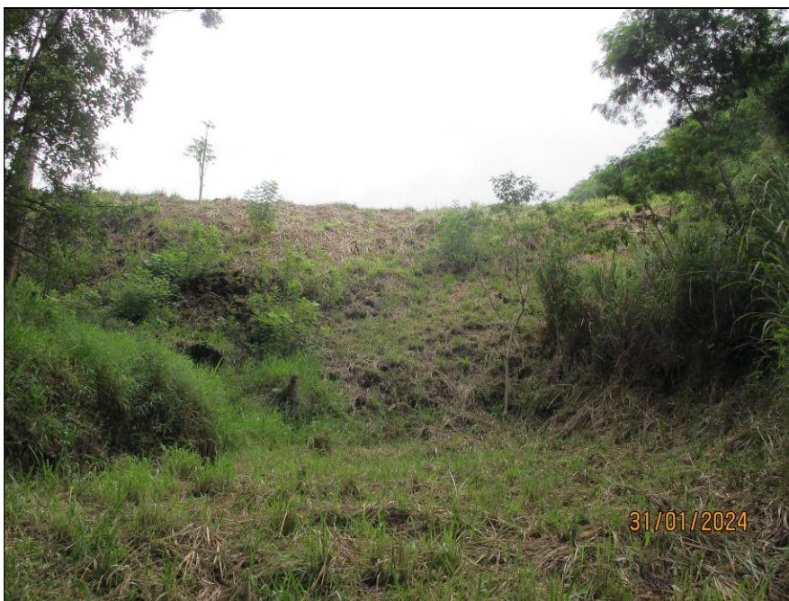
Figura 9.18- Vista do barramento a partir da região jusante – Jan/24.
