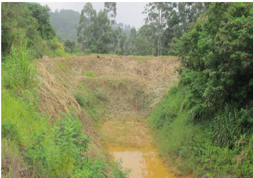
Figura 9.12- Talude de montante – Ausência de anomalias.
