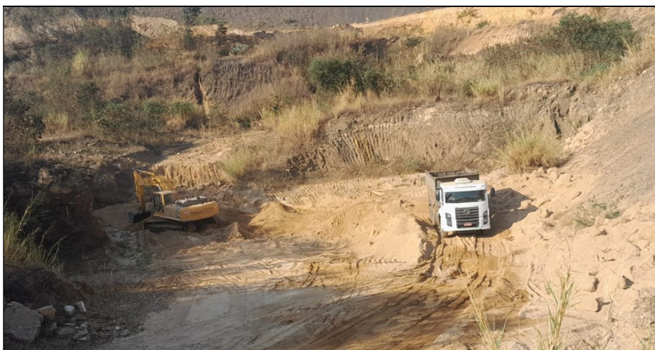
Figura 6.5- Operação de desassoreamento da bacia de decantação auxiliar a montante do dique D-03 – Ago/23.
