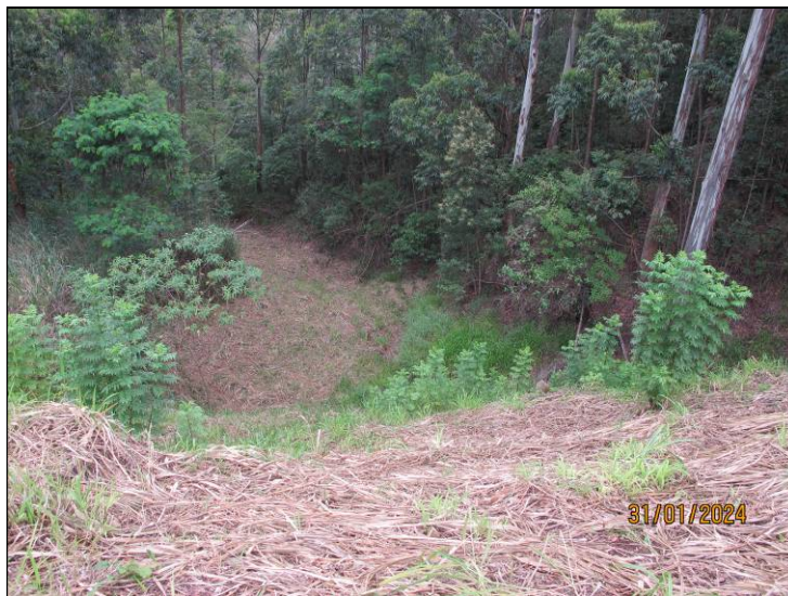
Figura 9.19- Vista da região de jusante a partir da crista do barramento.
