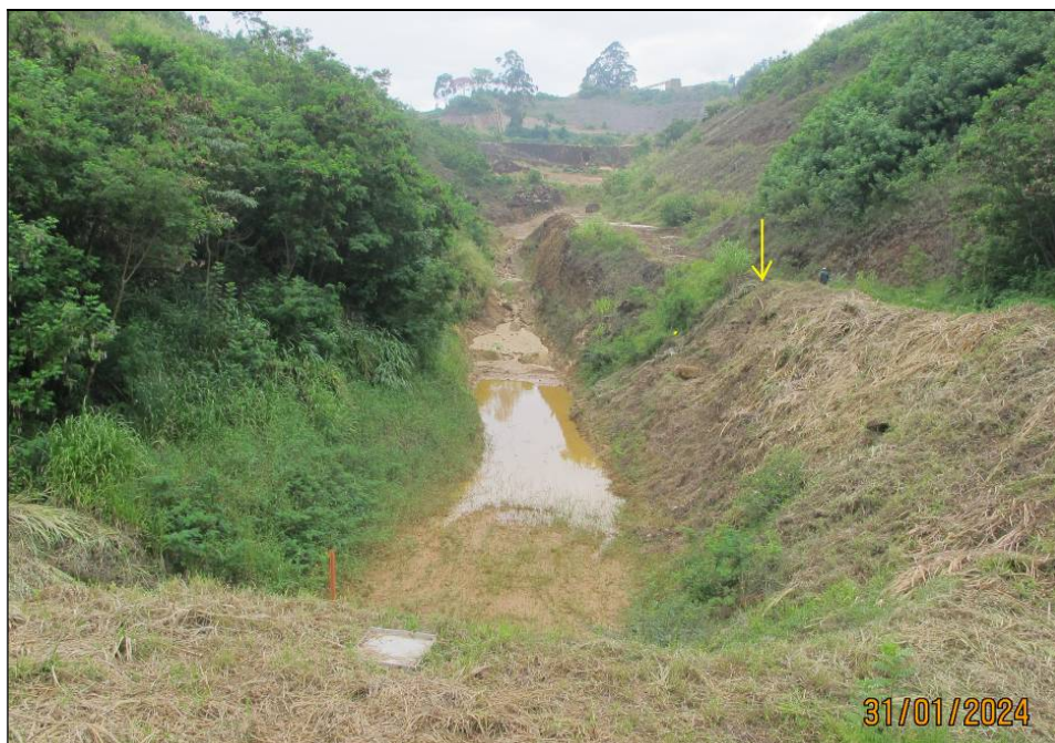
Figura 9.9- Escada de transferência localizada próxima à ombreira esquerda.
