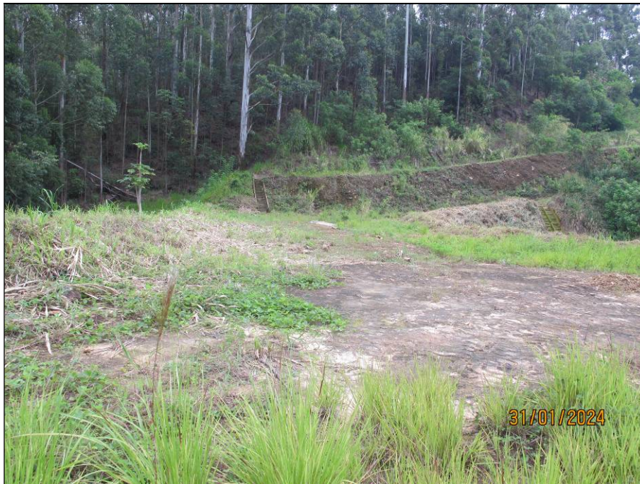
Figura 9.4- Vista da crista do barramento e da ombreira direita do dique D-03
