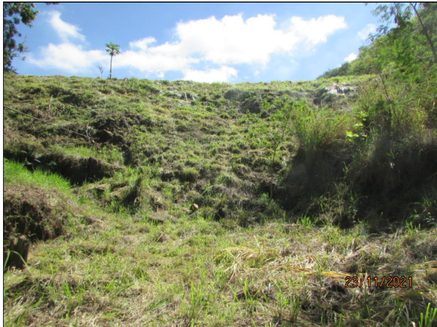
Figura 9.15- Vista do barramento a partir da região jusante – Nov/21.
