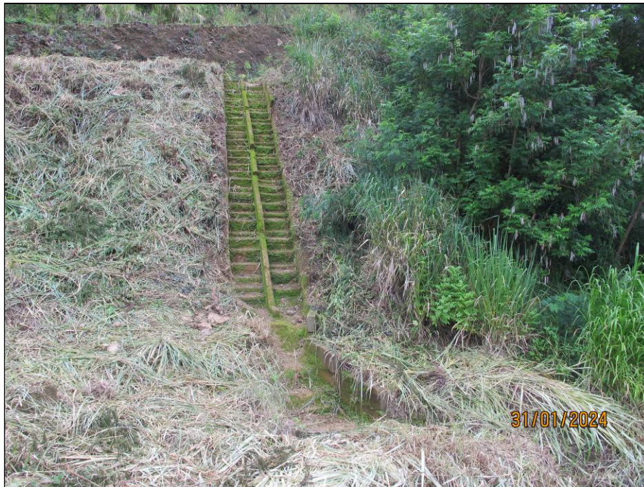
Figura 9.6- Vista do ponto de emboque da escada de transferência localizada próxima à ombreira direita.
