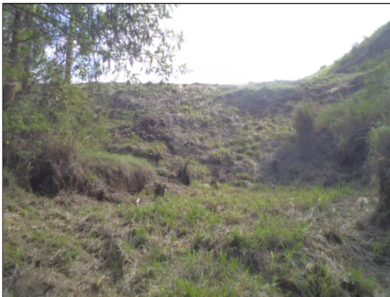
Figura 9.13- Vista do barramento a partir da região jusante – Nov/19.
