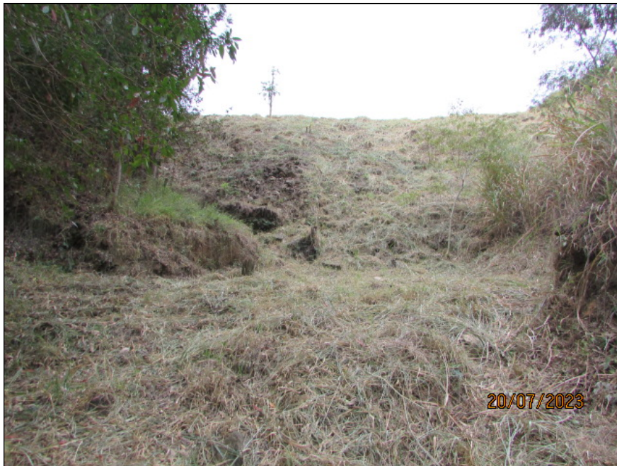
Figura 9.17- Vista do barramento a partir da região jusante – Jul/23.
