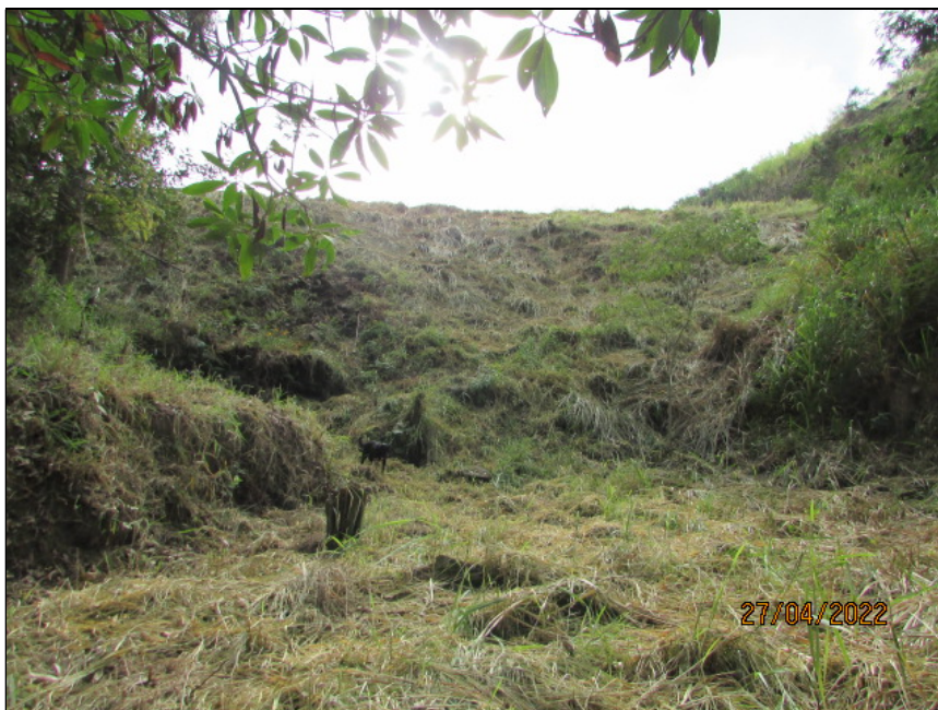
Figura 9.16- Vista do barramento a partir da região jusante – Abr/22.
