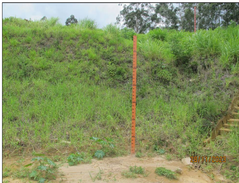
Figura 6.7- Régua linimétrica N° 2 para a medição dos níveis de assoreamento e da lâmina d'água.
