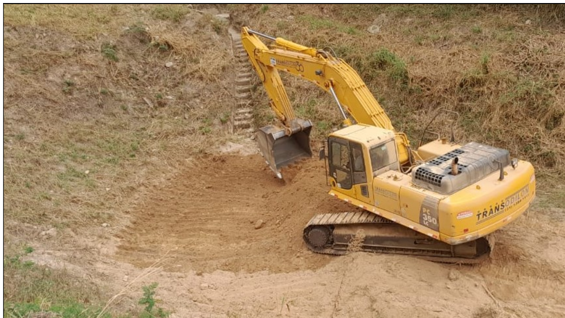
Figura 6.9- Operação de desassoreamento do dique D-03 – Ago/23.
