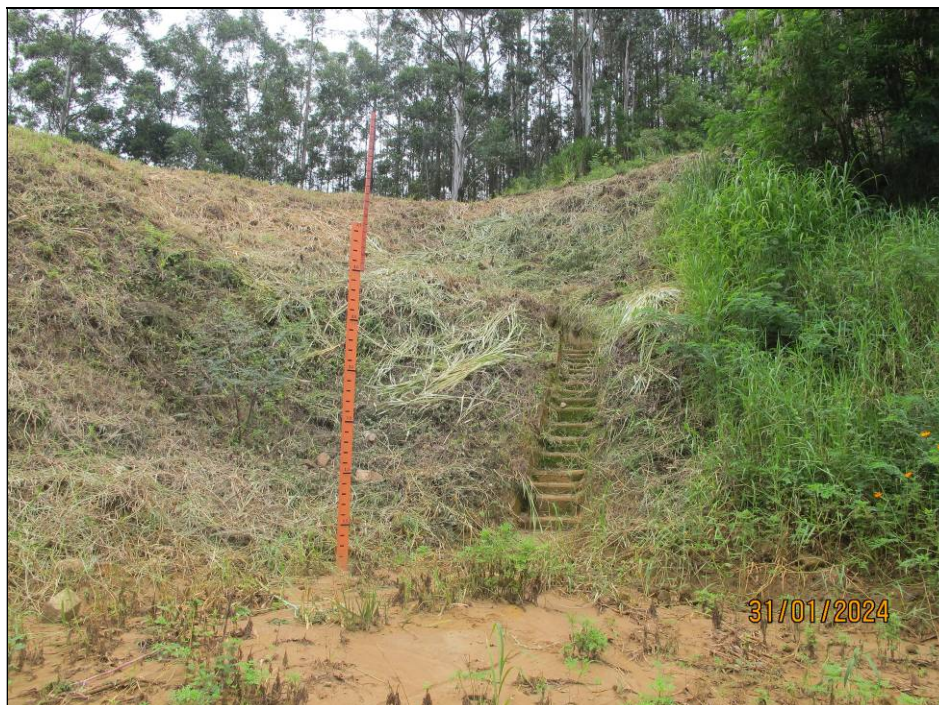
Figura 9.7- Vista do ponto de emboque da escada de transferência localizada próxima à ombreira direita.
