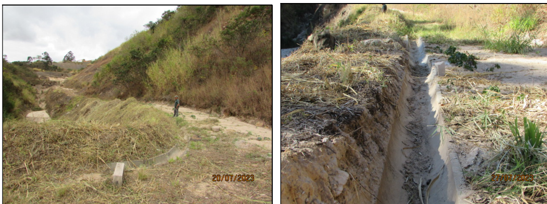
Figura 4.8- Canaleta de drenagem localizada na crista do talude de montante para a condução do fluxo até a escada localizada próxima à ombreira esquerda.
