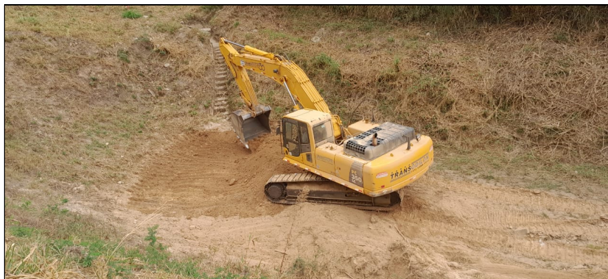
3.12- Registro de 25/08/2023– Operação de desassoreamento anual do reservatório.
