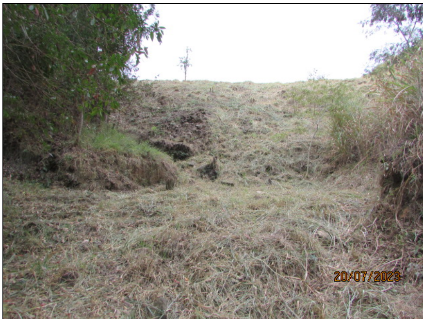
Figura 4.17- Vista do barramento a partir da região jusante – Jul/23.
