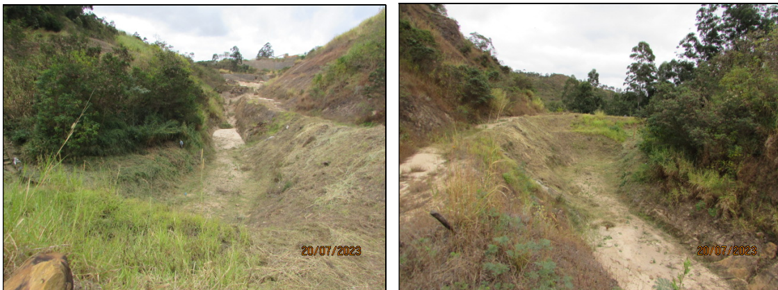
3.11- Registro de 20/07/2023– Reservatório “seco”.
