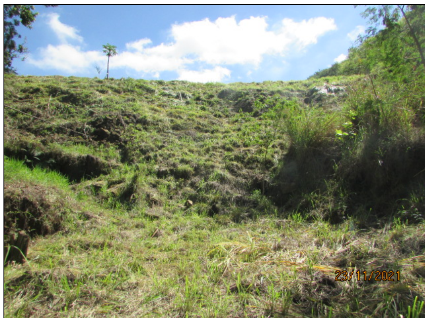
Figura 4.15- Vista do barramento a partir da região jusante – Nov/21.
