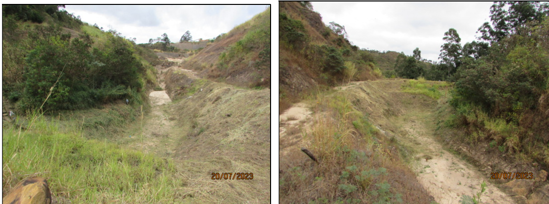
Figura 4.11- Vista do talude de montante e reservatório do dique D-03 – 20/07/2023.
