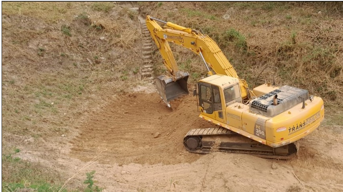
Figura 3.2- Operação de desassoreamento do dique D-03 – Ago/23.
