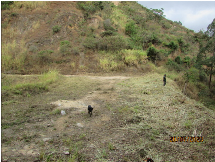
Figura 4.6- Vista da crista do barramento e da ombreira esquerda do dique D-03.
