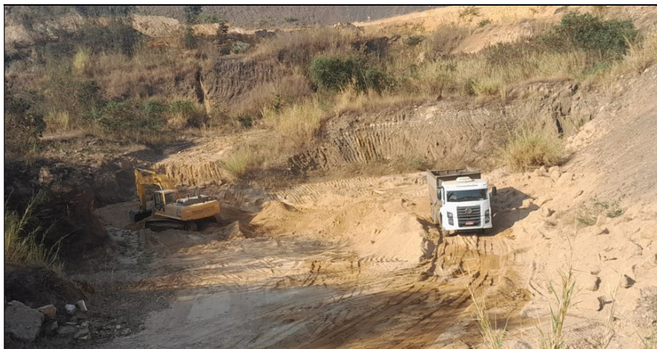
Figura 3.1- Operação de desassoreamento da bacia de decantação auxiliar – Ago/23.
