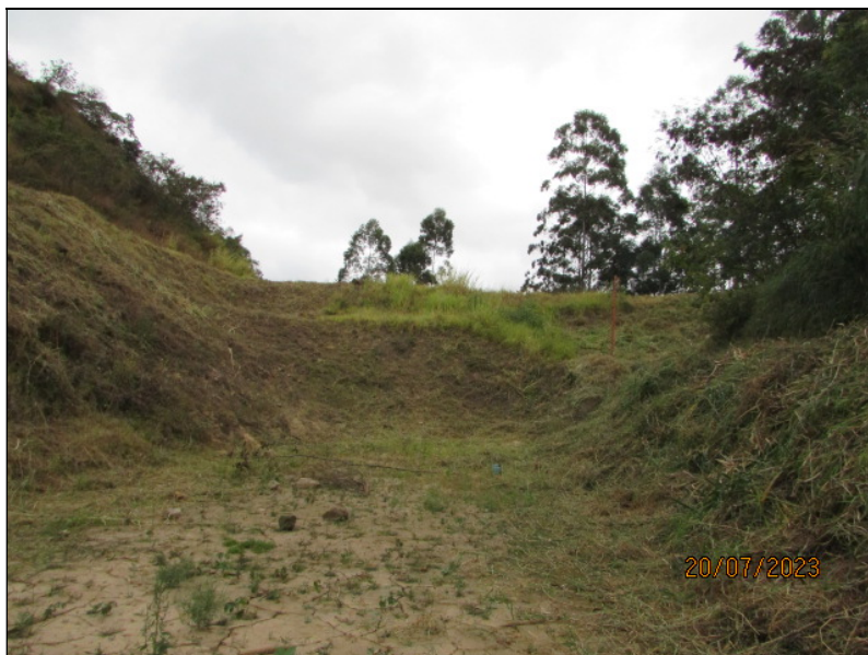
Figura 4.12- Talude de montante – Ausência de anomalias.
