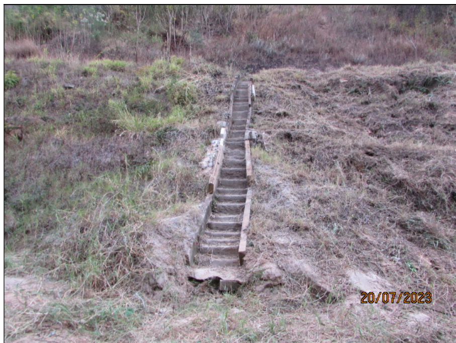
Figura 4.10- Detalhe da escada localizada próxima à ombreira esquerda.
