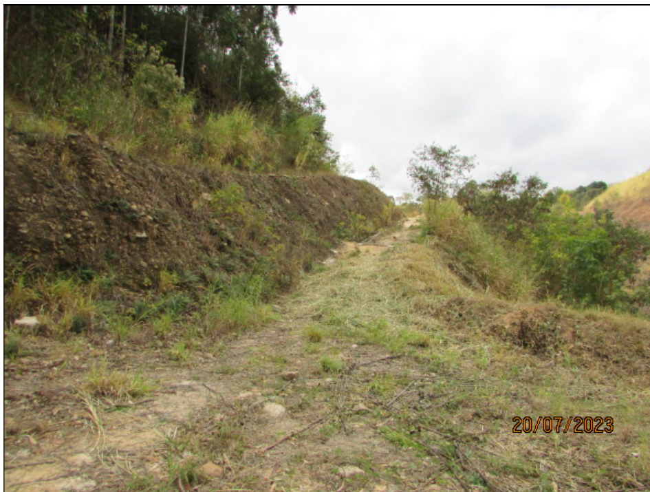
Figura 4.1- Vista da estrada de acesso à crista do barramento.
