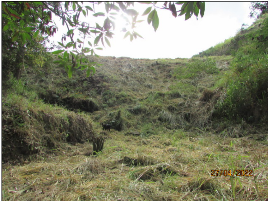
Figura 4.16- Vista do barramento a partir da região jusante – Abr/22.
