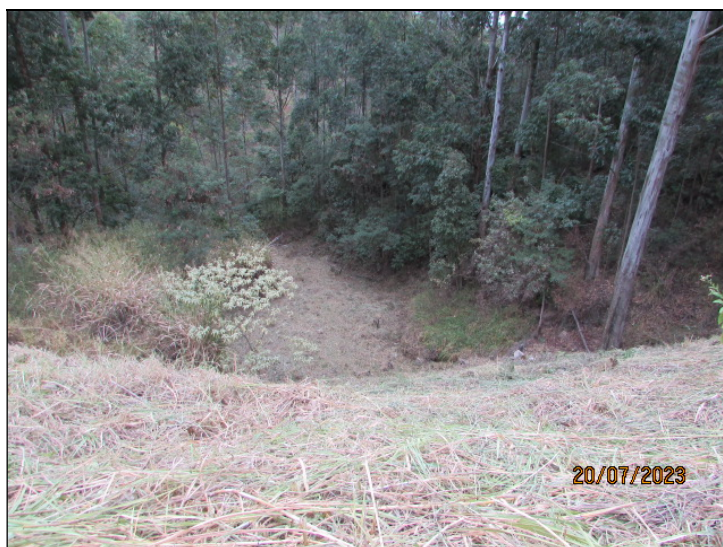
Figura 4.18- Vista da região de jusante a partir da crista do barramento.
