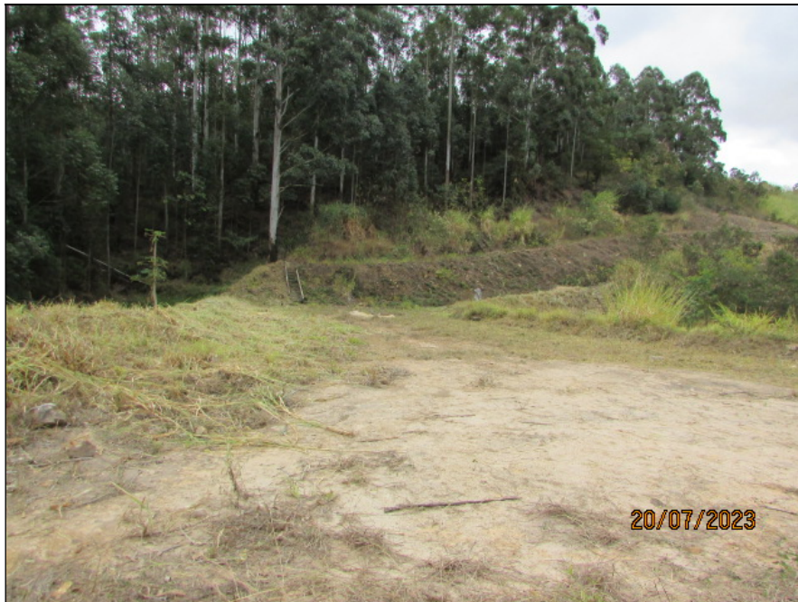
Figura 4.5- Vista da crista do barramento e da ombreira direita do dique D-03
