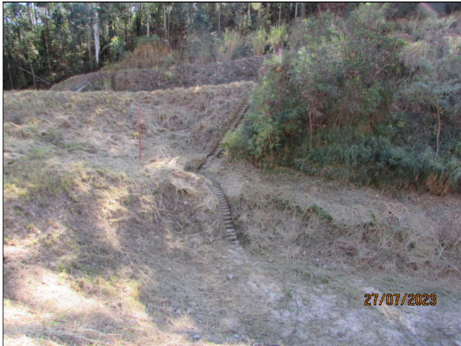
Figura 4.7- Escada de transferência localizada próxima à ombreira direita.
