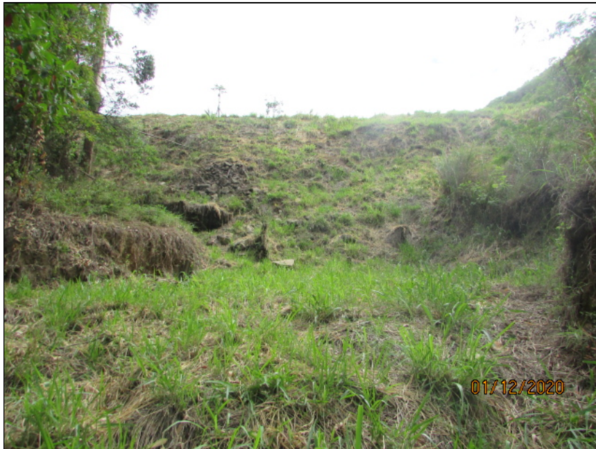
Figura 4.14- Vista do barramento a partir da região jusante – Jan/21.
