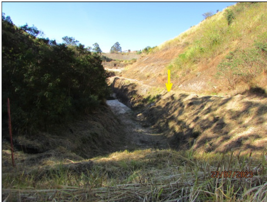
Figura 4.9- Escada de transferência localizada próxima à ombreira esquerda.
