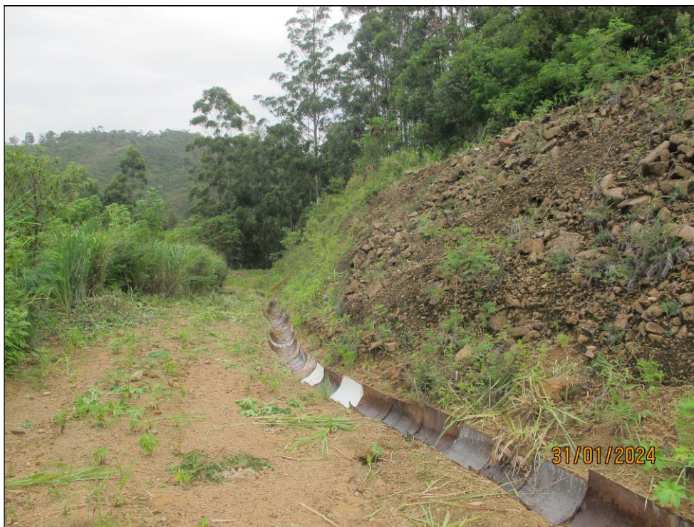
Figura 4.1- Vista da estrada de acesso à crista do barramento e do sistema de drenagem superficial principal.
