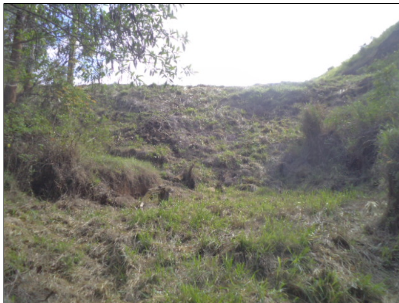
Figura 4.13- Vista do barramento a partir da região jusante – Nov/19.
