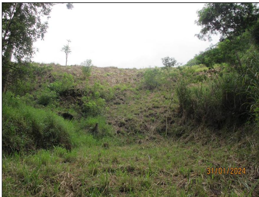
Figura 4.18- Vista do barramento a partir da região jusante – Jan/24.
