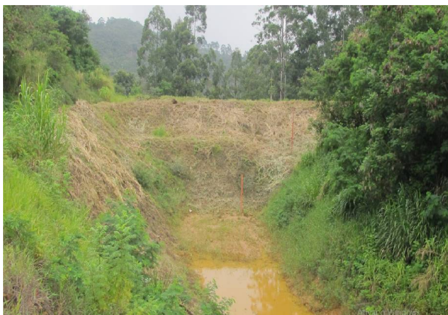
Figura 4.12- Talude de montante – Ausência de anomalias.
