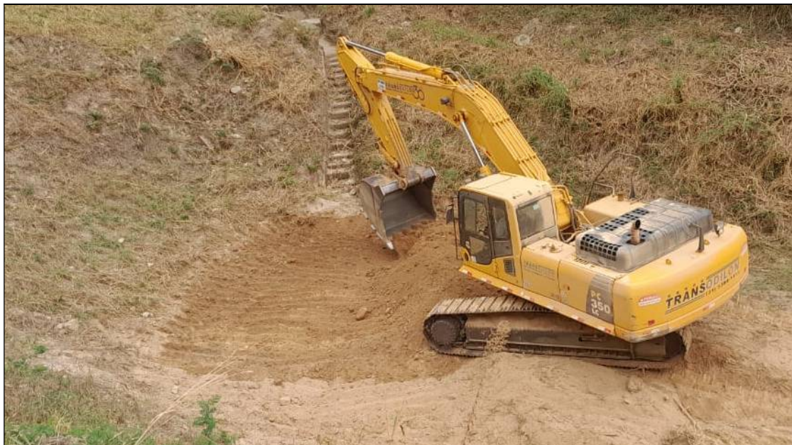
Figura 3.2- Operação de desassoreamento do dique D-03 – Ago/23.
