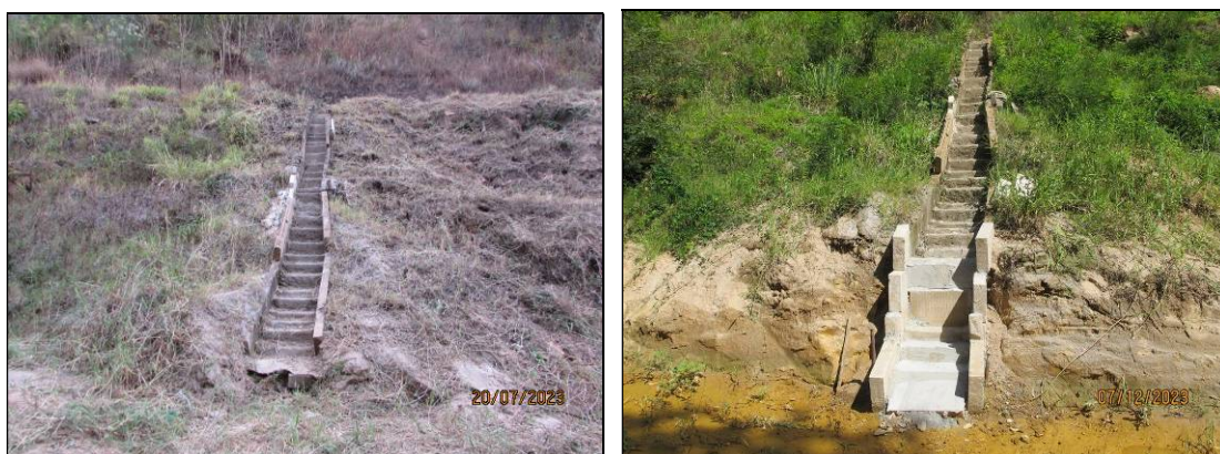
Figura 4.21- Reparo na base da escada localizada próxima à ombreira esquerda.
