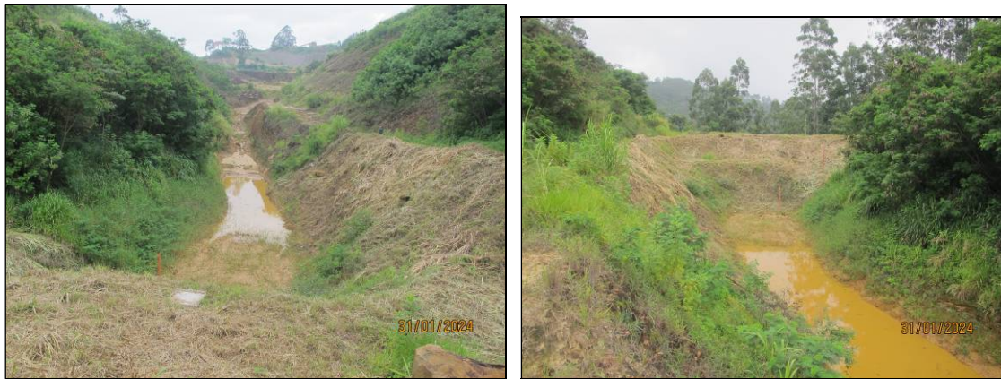
Figura 4.11- Vista do talude de montante e reservatório do dique D-03 – 31/01/2024.
