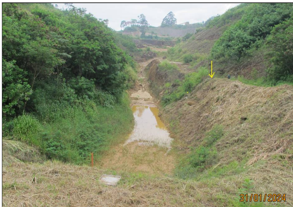
Figura 4.10- Escada de transferência localizada próxima à ombreira esquerda.
