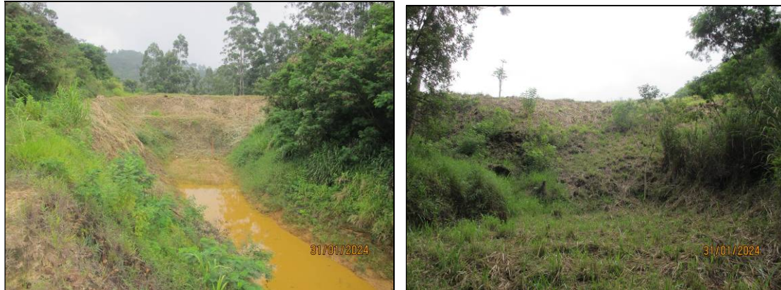
Figura 3.3- Vista dos taludes de montante e de jusante após a operação rotineira de capina da face dos taludes.
