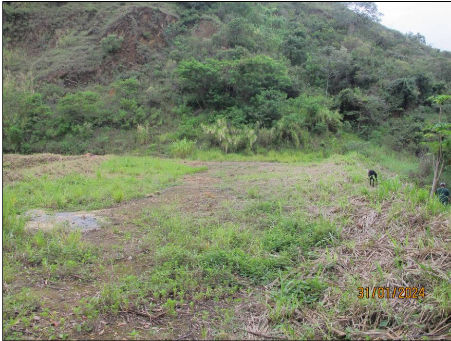
Figura 4.5- Vista da crista do barramento e da ombreira esquerda do dique D-03.
