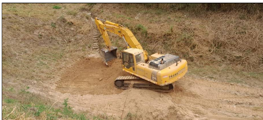
3.8- Registro de 25/08/2023– Operação de desassoreamento anual do reservatório.
