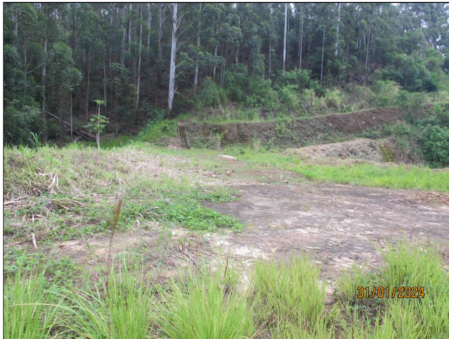
Figura 4.4- Vista da crista do barramento e da ombreira direita do dique D-03
