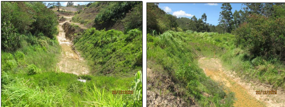
Figura 3.12- Registro de 20/12/23 – Reservatório “seco”.
