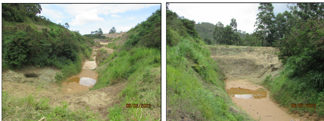
21- Registro de 06/02/2023 – Reservatório praticamente “seco” – Pequena poça d’água no interior do reservatório.
