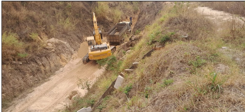
40- Registro de 25/08/2023– Operação de desassoreamento do dique D-03.
