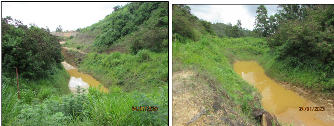
19- Registro de 24/01/2023– Reservatório com pequeno volume de água acumulada.
