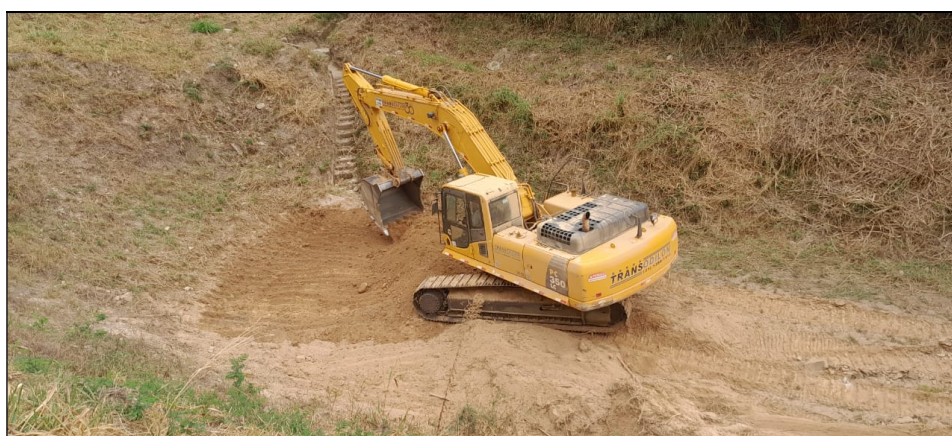
39- Registro de 25/08/2023– Operação de desassoreamento do dique D-03.
