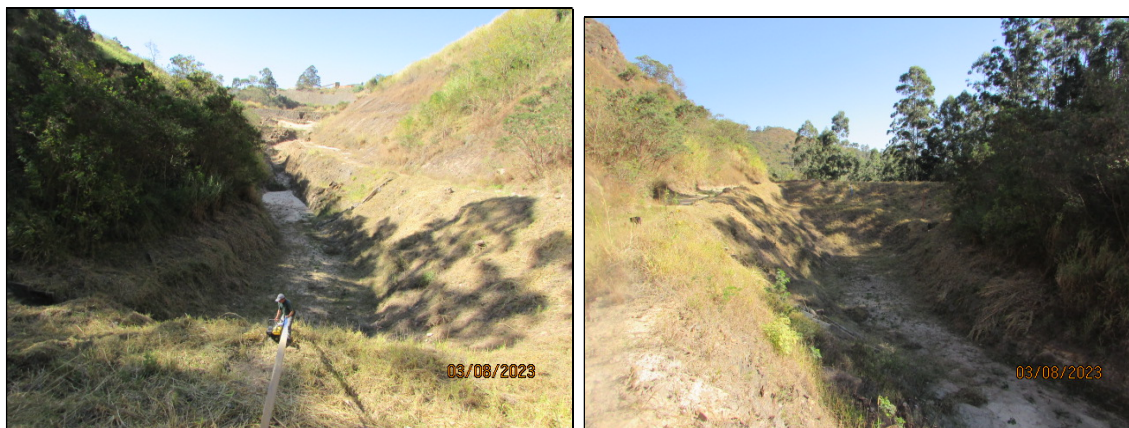
37- Registro de 03/08/2023– Reservatório “seco”.
