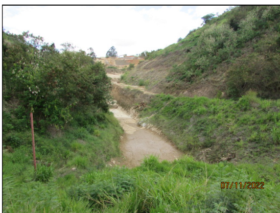
9- Registro de 07/11/2022– Reservatório “úmido”, sem lâmina d’água no interior.
