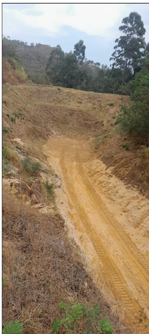
41- Registro de 25/08/2023– Reservatório do dique D-03 após a operação de desassoreamento.
