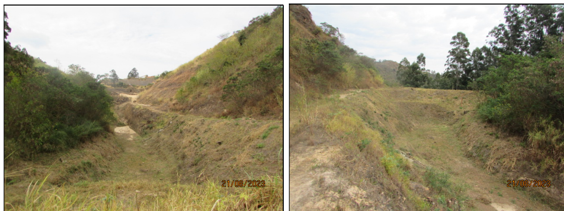
38- Registro de 21/08/2023– Reservatório “seco”.
