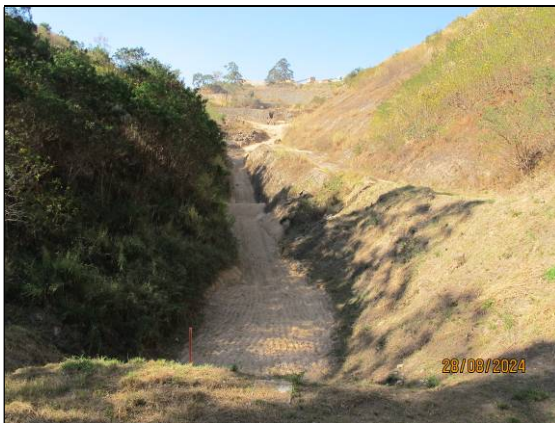
47- Registro de 28/08/2024– Reservatório completamente “seco”. Altura da lâmina d’água – h = 0 cm / Percentual de assoreamento do reservatório: 0,00 %.
