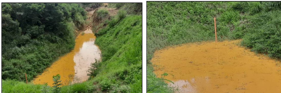
Figura 30- Registro de 28/03/24 – Pequeno volume de água acumulada no reservatório – Altura da lâmina d'água – h = 60 cm.
