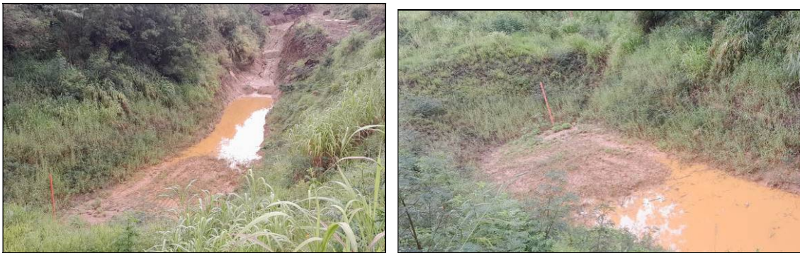
Figura 20- Registro de 06/01/24 – Pequeno acúmulo de água no reservatório, porém sem alcançar a face do talude de montante.
