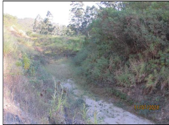
40- Registro de 11/07/24 – Reservatório completamente “seco”. Altura da lâmina d’água – h = 0 cm / Percentual de assoreamento do reservatório: 1,25 %.
