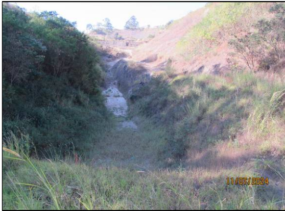
40- Registro de 11/07/24 – Reservatório completamente “seco”. Altura da lâmina d’água – h = 0 cm / Percentual de assoreamento do reservatório: 1,25 %.
