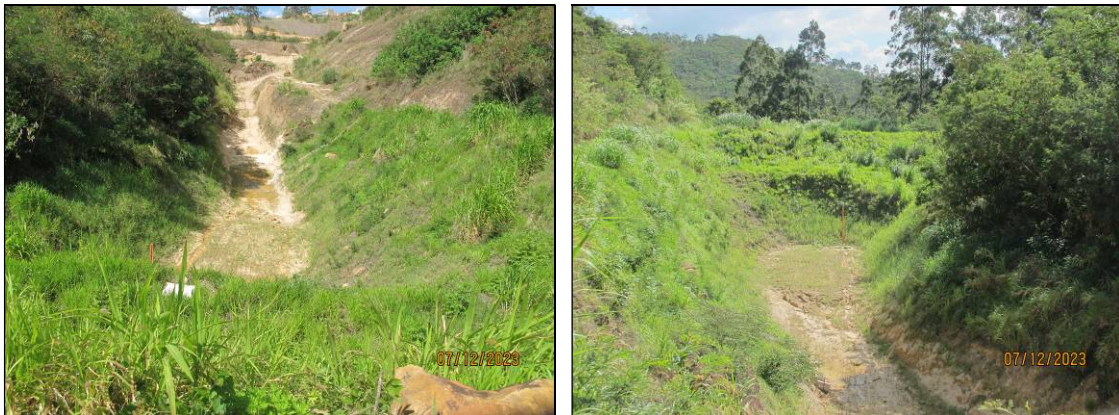
Figura 16- Registro de 07/12/23 – Reservatório “seco”.
