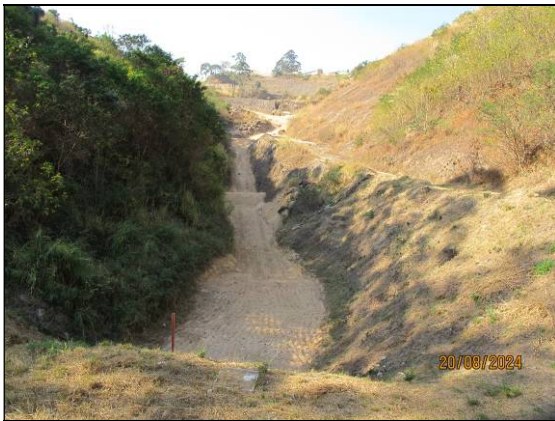
46- Registro de 20/08/2024– Reservatório do dique D-03 após a operação de desassoreamento completamente “seco”. Altura da lâmina d’água – h = 0 cm / Percentual de assoreamento do reservatório: 0,00 %.
