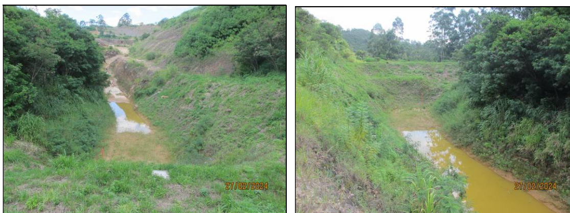
Figura 26- Registro de 27/02/24 – Diminuição da lâmina d'água acumulada no reservatório.
