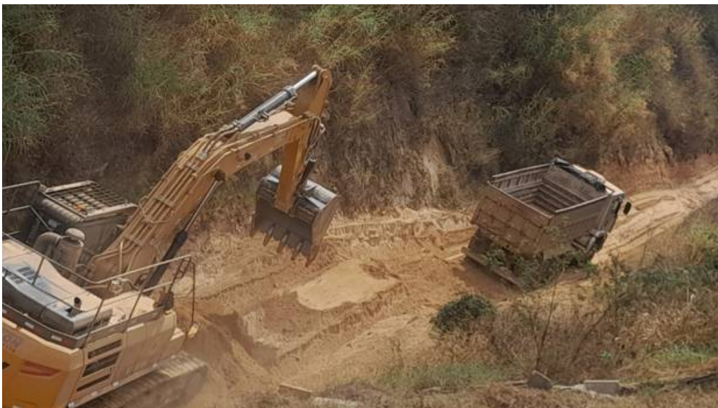
45- Registro de 14/08/2024– Operação de desassoreamento do dique D-03.
