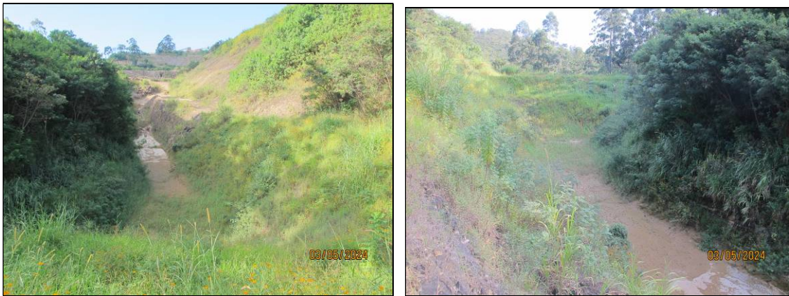
Figura 34- Registro de 03/05/24 – Reservatório completamente “seco”.
