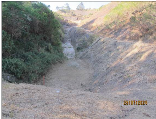
41- Registro de 25/07/24 – Reservatório completamente “seco”. Realizada a roçada dos taludes para a inspeção regular.
