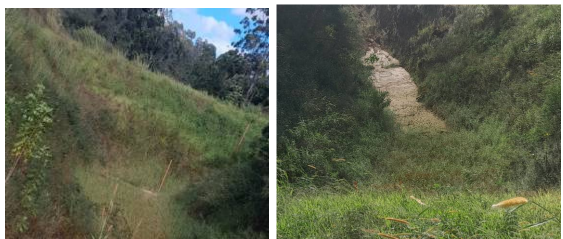
Figura 36- Reservatório completamente “seco”. - Altura da lâmina d’água – h = 0 cm / Percentual de assoreamento do reservatório: 1,25 %.
