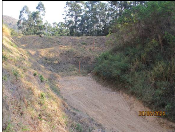
46- Registro de 20/08/2024– Reservatório do dique D-03 após a operação de desassoreamento completamente “seco”. Altura da lâmina d’água – h = 0 cm / Percentual de assoreamento do reservatório: 0,00 %.
