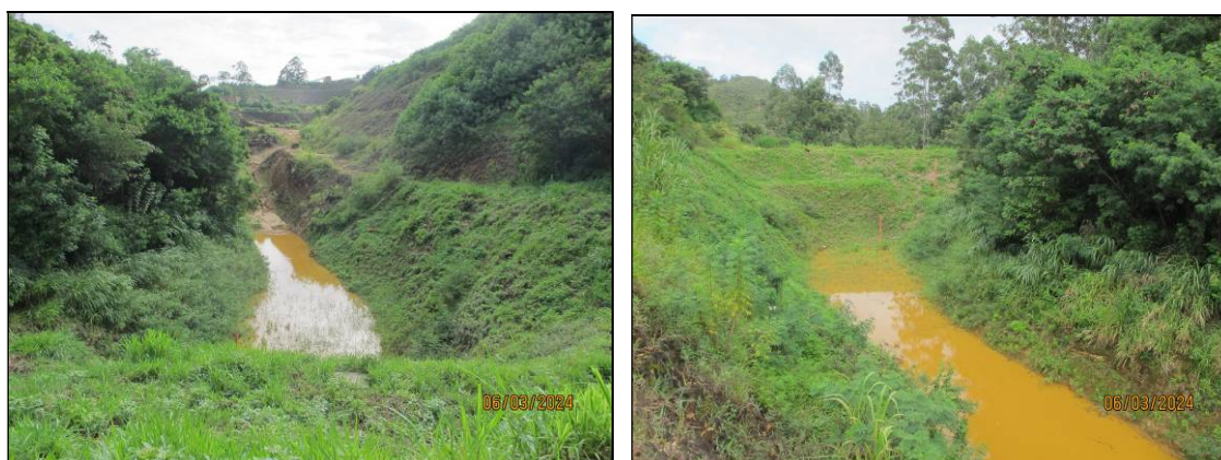
Figura 27- Registro de 06/03/24 – Pequena lâmina de água acumulada no fundo do reservatório - Altura da lâmina d'água – h = 5 cm / Percentual de assoreamento do reservatório: 0,80%.
