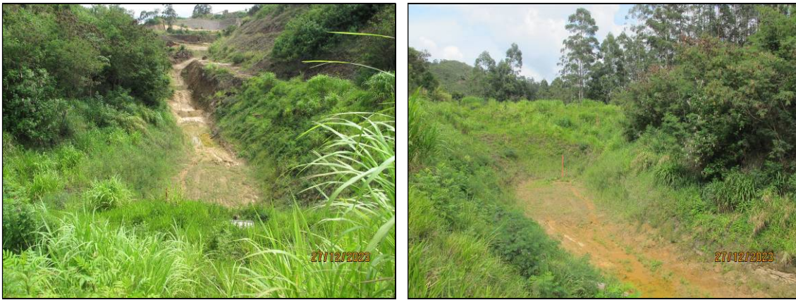
Figura 19- Registro de 27/12/23 – Reservatório “seco” - Percentual de assoreamento: 0,00%.
