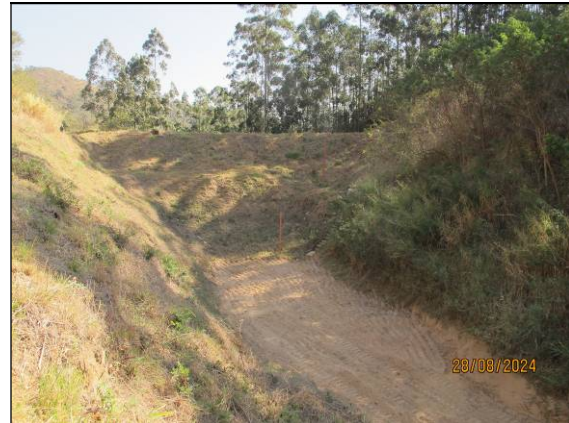
47- Registro de 28/08/2024– Reservatório completamente “seco”. Altura da lâmina d’água – h = 0 cm / Percentual de assoreamento do reservatório: 0,00 %.
