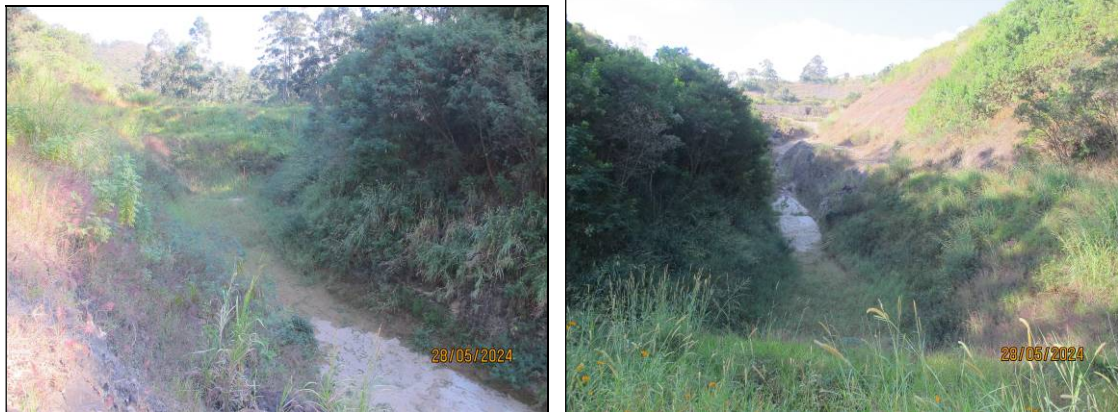
Figura 37- Registro de 28/05/24 – Reservatório completamente “seco”.
