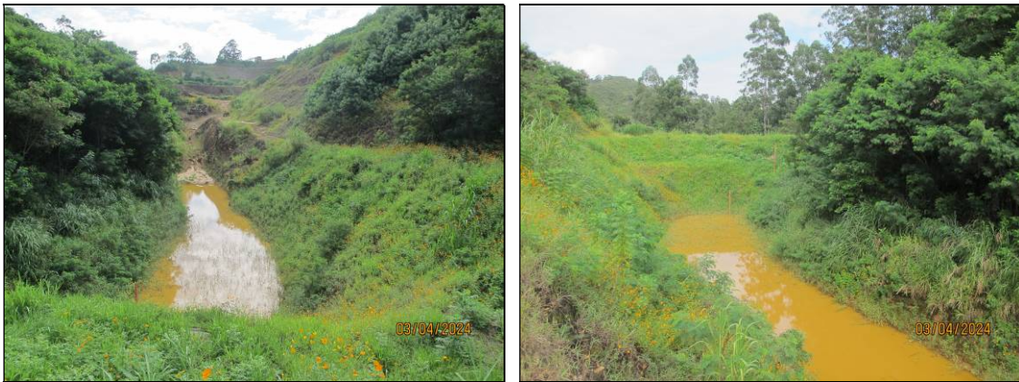
Figura 31- Registro de 03/04/24 – Pequena lâmina de água acumulada no fundo do reservatório - Altura da lâmina d’água – h = 5 cm / Percentual de assoreamento do reservatório: 1,25 %.
