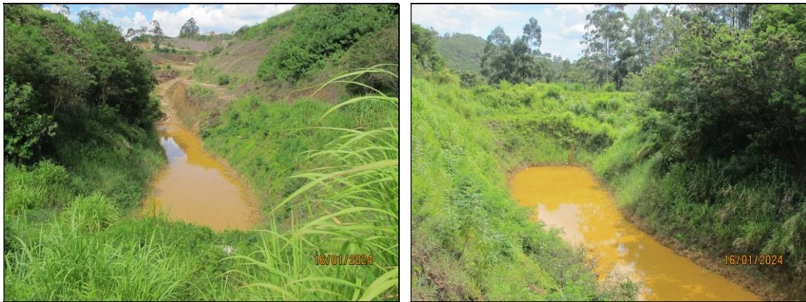
Figura 22- Registro de 16/01/24 – Pequena lâmina de água acumulada no fundo do reservatório - Altura da lâmina d'água – h = 5 cm / Percentual de assoreamento do reservatório: 0,00%.
