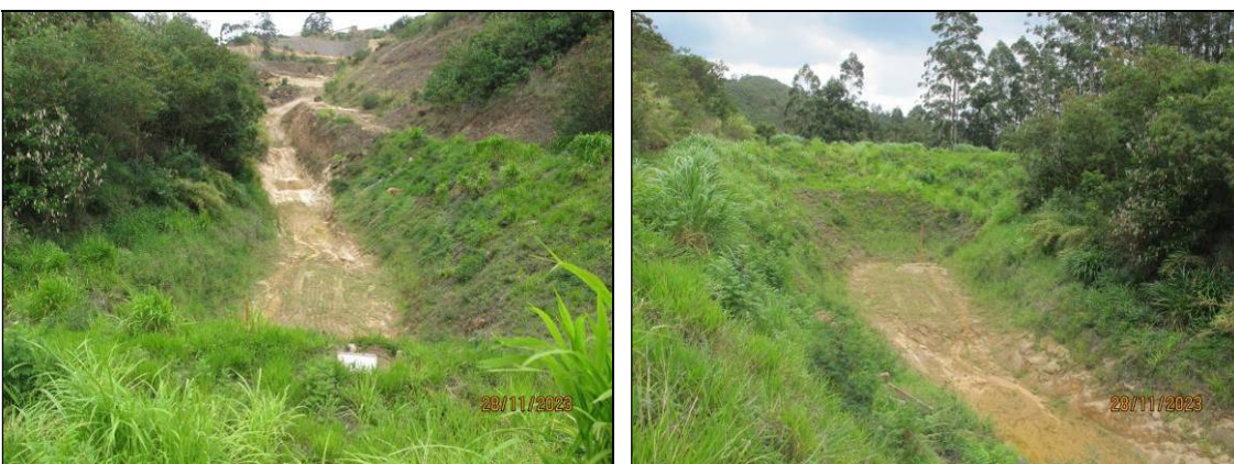
Figura 15- Registro de 28/11/23 – Reservatório “seco”.
