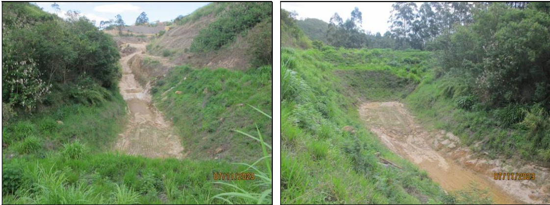
Figura 13- Registro de 07/11/23 – Reservatório “seco”.
