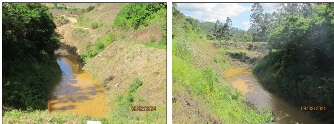
Figura 25- Registro de 09/02/24 – Pequeno volume de água acumulada no reservatório - Altura da lâmina d'água não alcança a régua de leitura / Percentual de assoreamento do reservatório: 0,625%.
