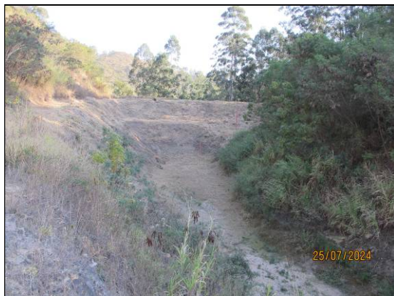
41- Registro de 25/07/24 – Reservatório completamente “seco”. Realizada a roçada dos taludes para a inspeção regular.
