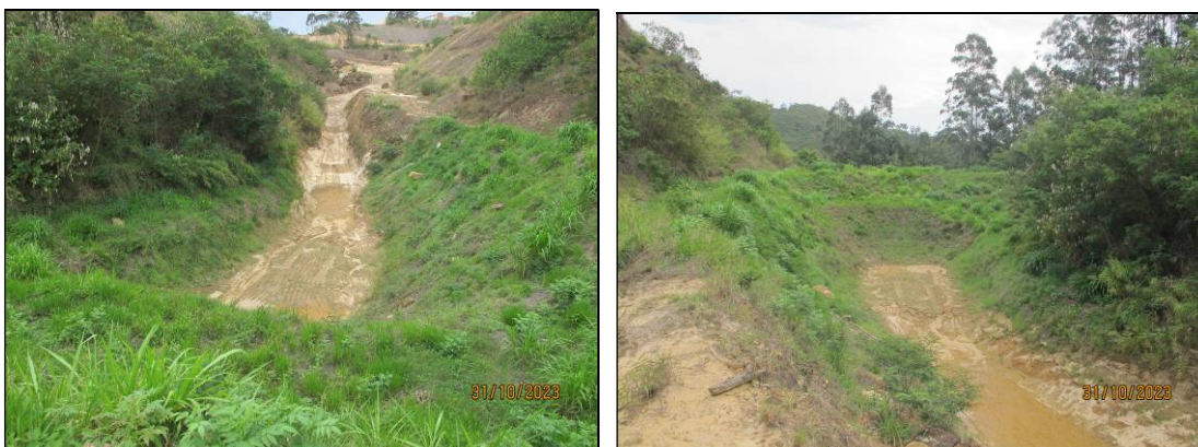
Figura 12- Registro de 31/10/23 – Reservatório “seco”.
