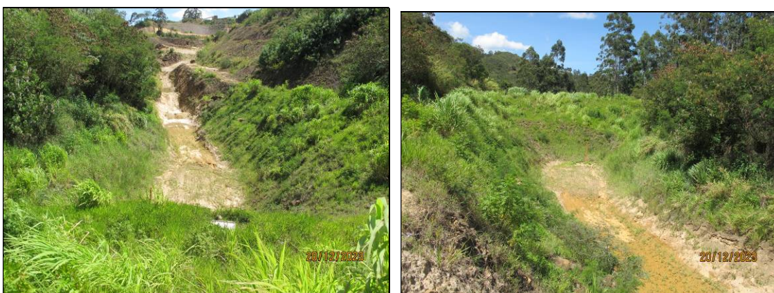
Figura 18- Registro de 20/12/23 – Reservatório “seco”.
