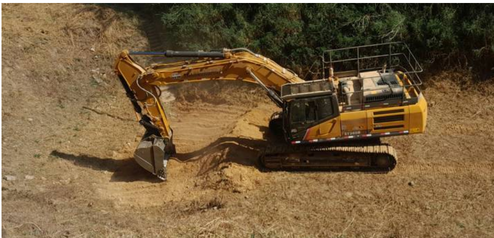
44- Registro de 14/08/2024– Operação de desassoreamento do dique D-03.
