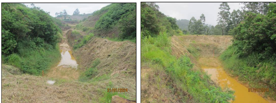
Figura 24- Registro de 31/01/24 – Diminuição da lâmina d'água acumulada no reservatório.
