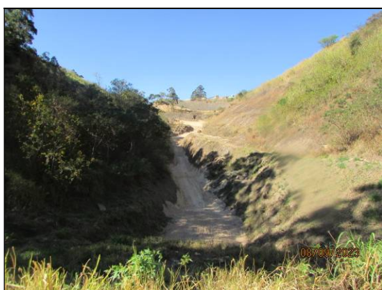
Figura 3- Registro de 08/09/23 – Vista da condição do reservatório do dique D-03, após a operação de desassoreamento (“seco” e na capacidade máxima de armazenamento - Percentual de assoreamento: 0,00%).
