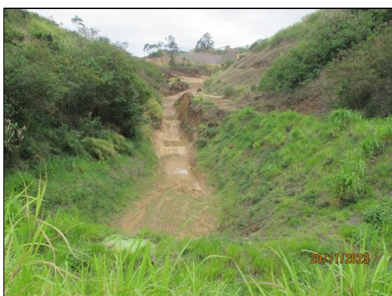
5- Registro de 20/11/23 – Reservatório “seco” - Percentual de assoreamento: 0,00%.
