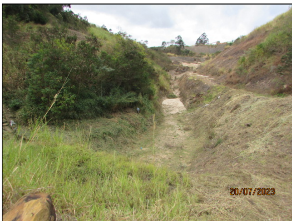
1- Registro de 20/07/2023– Reservatório “seco” – Percentual de assoreamento: 1,50%.
