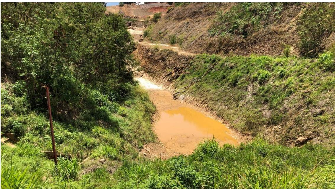
**Figura 0.8: Reservatório e régua linimétrica vistos da crista da barragem**
