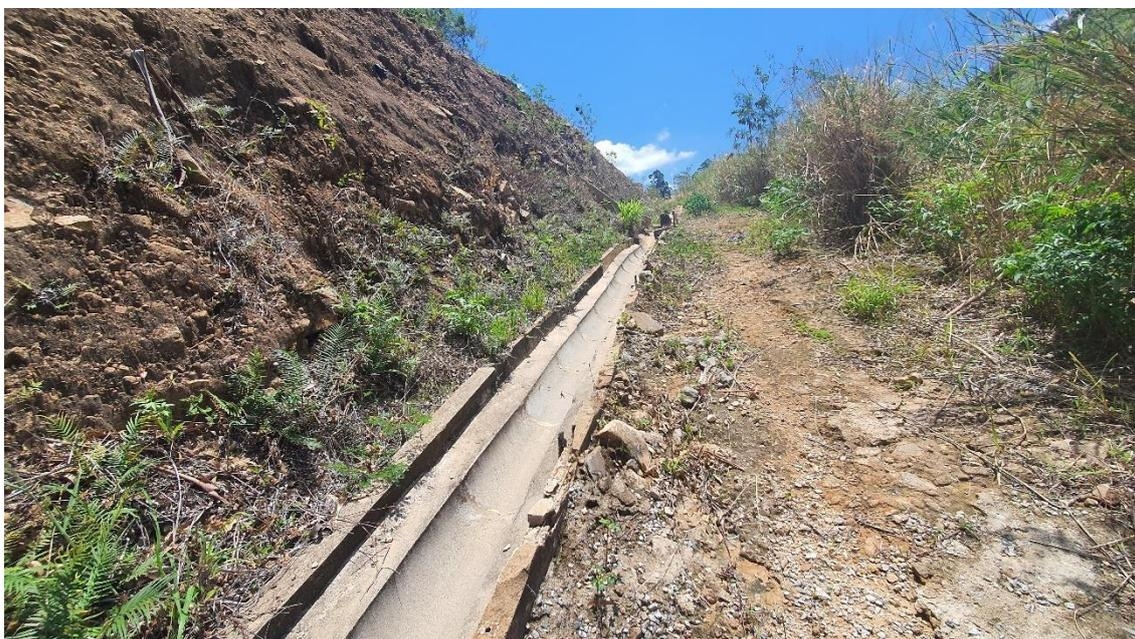
**Figura 0.1: Trilha de acesso a barragem com sistema de drenagem**
