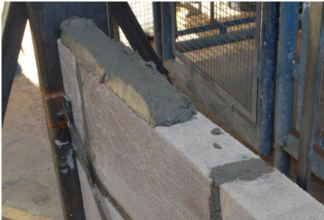
Fotografia 3 – Detalhe da aplicação da argamassa de assentamento dos blocos.
