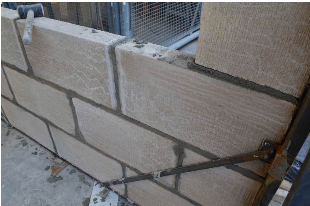
Fotografia 2 – Assentamento dos blocos no quadro de ensaio auxiliar para a execução da parede.
