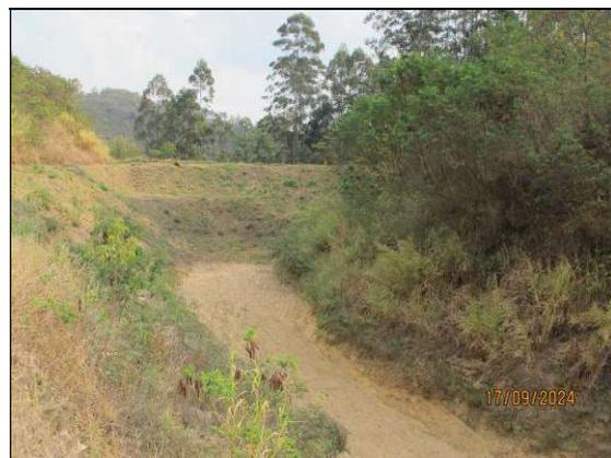
3- Registro de 17/09/2024– Reservatório completamente “seco”. Altura da lâmina d’água –  $h = 0$  cm / Percentual de assoreamento do reservatório: 0,00 %.
