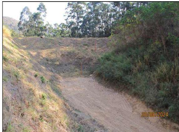
2 - Registro de 20/08/2024– Reservatório do dique D-03 após a operação de desassoreamento. Completamente “seco”. Altura da lâmina d’água –  $h = 0$  cm / Percentual de assoreamento do reservatório: 0,00 %.
