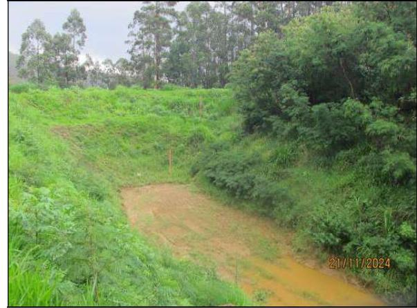
5- Registro de 21/11/2024– Reservatório úmido, com uma pequena poça acumulada no interior. Altura da lâmina d’água – h = 0 cm / Percentual de assoreamento do reservatório: 0,00%.
