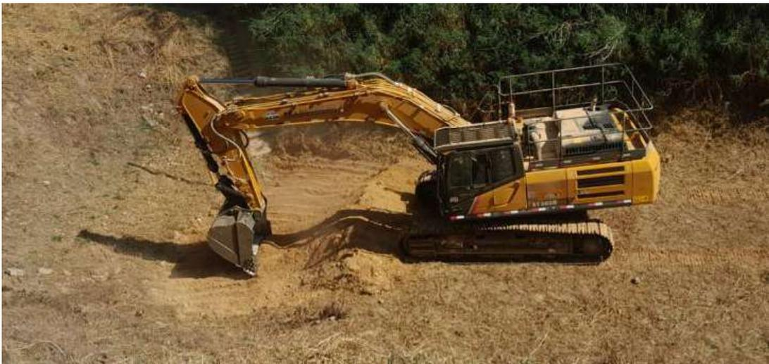
7- Registro de 14/08/2024– Operação de desassoreamento do dique D-03 / Retirada do material acumulado.
