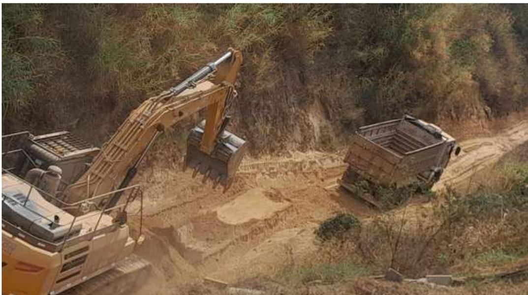
8- Registro de 14/08/2024– Operação de desassoreamento do dique D-03 / Carregamento e transporte do material de desassoreamento.
