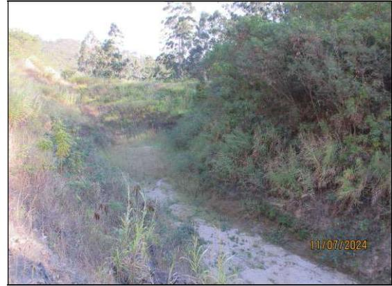
1- Registro de 11/07/24 – Reservatório completamente “seco”. Altura da lâmina d’água –  $h = 0$  cm / Percentual de assoreamento do reservatório: 1,25 %.
