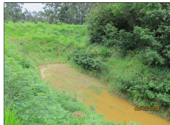
6- Registro de 03/12/2024– Reservatório úmido, com uma pequena poça acumulada no interior, porém sem alcançar a régua e o talude de montante. Altura da lâmina d’água – h = 0 cm / Percentual de assoreamento do reservatório: 0,00%.
