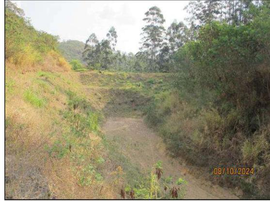
4- Registro de 08/10/2024– Reservatório completamente “seco”. Altura da lâmina d’água – h = 0 cm / Percentual de assoreamento do reservatório: 0,00 %.
