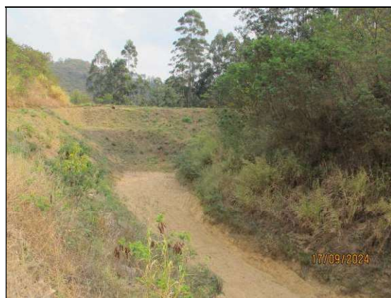
4.14- Registro de 17/09/2024 – Reservatório completamente “seco”. Altura da lâmina d’água – h = 0 cm / Percentual de assoreamento do reservatório: 0,00 %.
