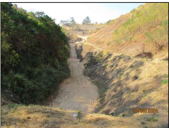
4.13- Registro de 20/08/2024 – Reservatório do dique D-03 após a operação de desassoreamento. Completamente “seco”. Altura da lâmina d’água – h = 0 cm / Percentual de assoreamento do reservatório: 0,00 %.
