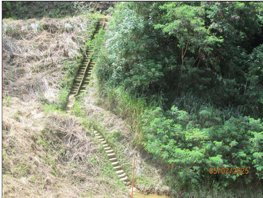
Figura 5.6- Vista da escada de transferência localizada próxima à ombreira direita.
