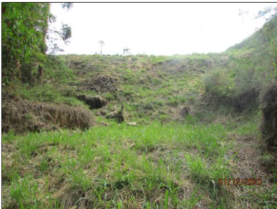
Figura 5.14- Vista do barramento a partir da região jusante – Jan/21.
