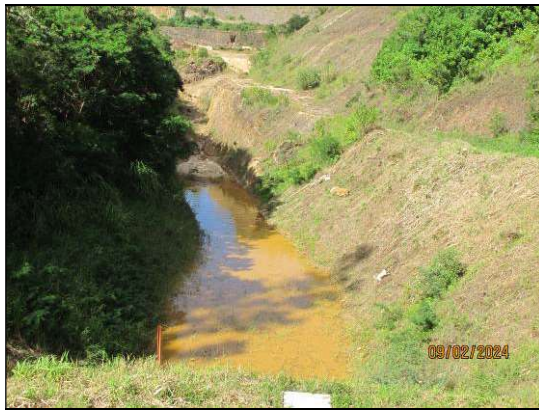
Figura 4.7- Registro de 09/02/24 – Pequeno volume de água acumulada no reservatório - Altura da lâmina d'água não alcança a régua de leitura / Percentual de assoreamento do reservatório: 0,625%.
