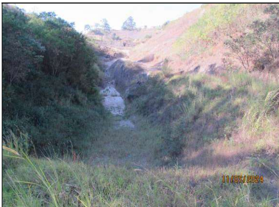
4.12- Registro de 11/07/24 – Reservatório completamente “seco”. Altura da lâmina d’água – h = 0 cm / Percentual de assoreamento do reservatório: 1,25 %.
