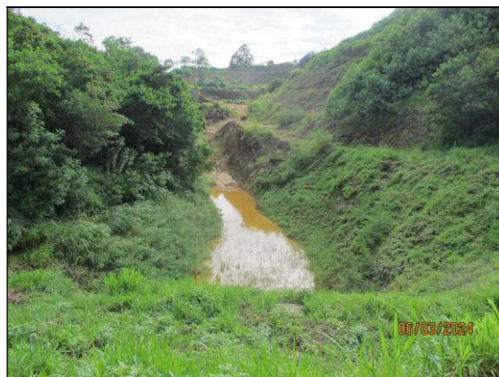
Figura 4.8- Registro de 06/03/24 – Pequena lâmina de água acumulada no fundo do reservatório - Altura da lâmina d'água – h = 5 cm / Percentual de assoreamento do reservatório: 0,80%.
