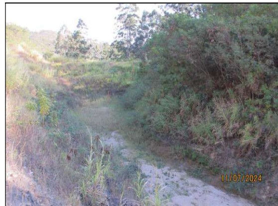
4.12- Registro de 11/07/24 – Reservatório completamente “seco”. Altura da lâmina d’água – h = 0 cm / Percentual de assoreamento do reservatório: 1,25 %.
