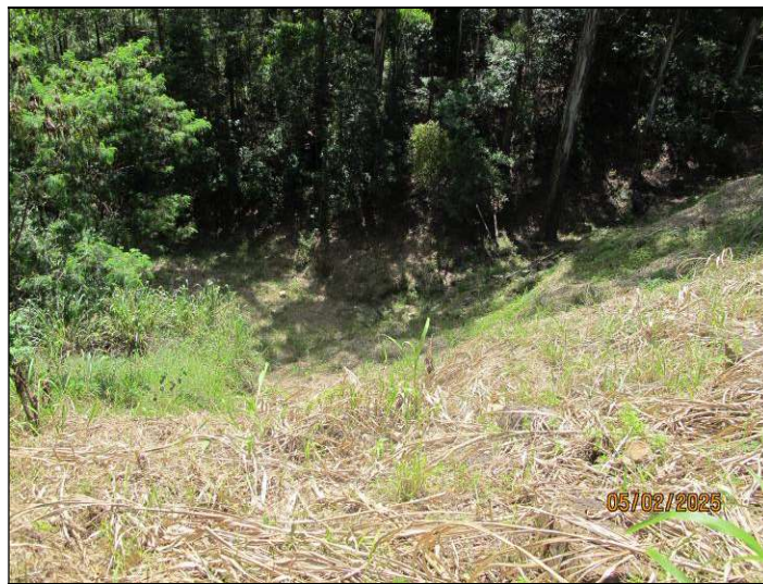
Figura 5.21- Vista da região de jusante a partir da crista do barramento.
