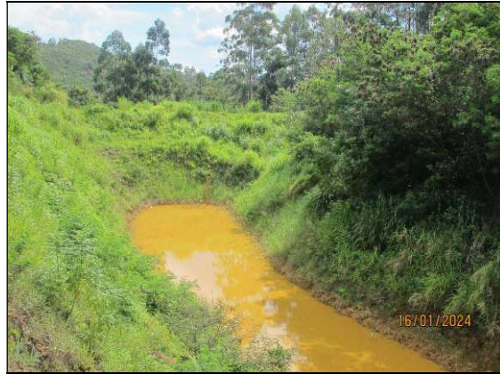
4.6- Registro de 16/01/24 – Pequena lâmina de água acumulada no fundo do reservatório - Altura da lâmina d'água – h = 5 cm / Percentual de assoreamento do reservatório: 0,00%.
