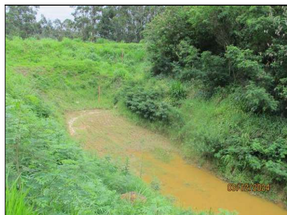
4.17- Registro de 03/12/2024– Reservatório úmido, com uma pequena poça acumulada no interior, porém sem alcançar a régua e o talude de montante. Altura da lâmina d’água – h = 0 cm / Percentual de assoreamento do reservatório: 0,00%.
