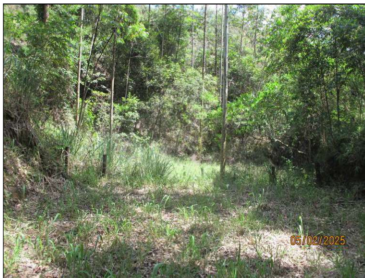
Figura 5.22- Vista da região de jusante a partir do pé do barramento.
