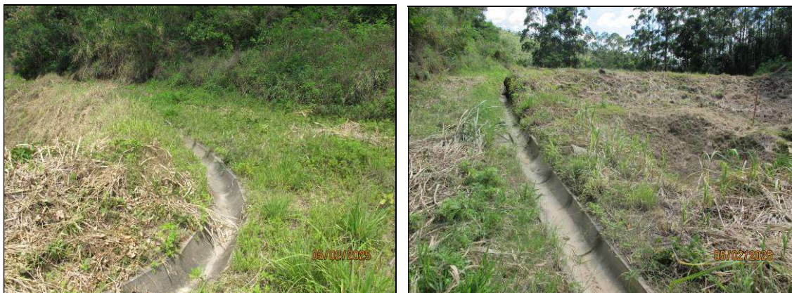
Figura 5.8- Canaleta de drenagem localizada na crista do talude de montante para a condução do fluxo até a escada localizada próxima à ombreira esquerda.
