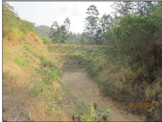
4.15- Registro de 08/10/2024 – Reservatório completamente “seco”. Altura da lâmina d’água – h = 0 cm / Percentual de assoreamento do reservatório: 0,00 %.
