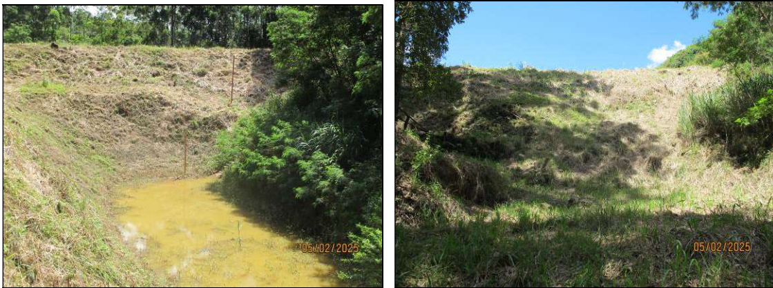
Figura 4.3- Vista dos taludes de montante e de jusante após a operação rotineira de capina da face dos taludes.
