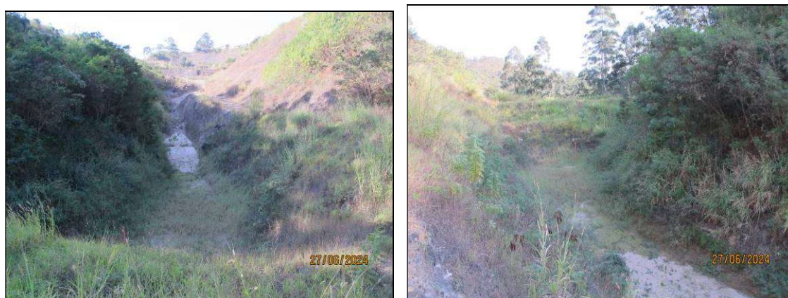
4.11- Registro de 27/06/24 – Reservatório completamente “seco”. - Altura da lâmina d'água – h = 0 cm / Percentual de assoreamento do reservatório: 1,25 %.
