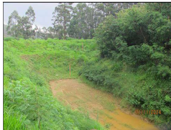
4.16- Registro de 21/11/2024 – Reservatório úmido, com uma pequena poça acumulada no interior. Altura da lâmina d’água – h = 0 cm / Percentual de assoreamento do reservatório: 0,00%.
