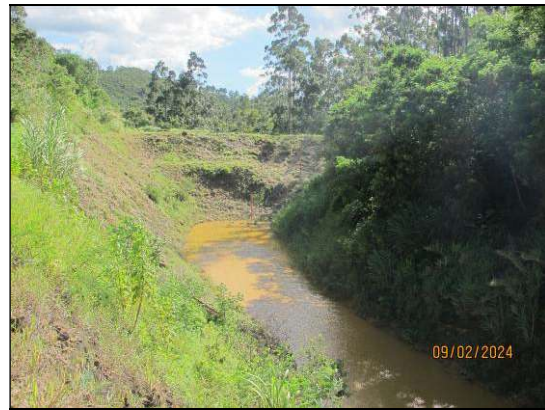
Figura 4.7- Registro de 09/02/24 – Pequeno volume de água acumulada no reservatório - Altura da lâmina d'água não alcança a régua de leitura / Percentual de assoreamento do reservatório: 0,625%.
