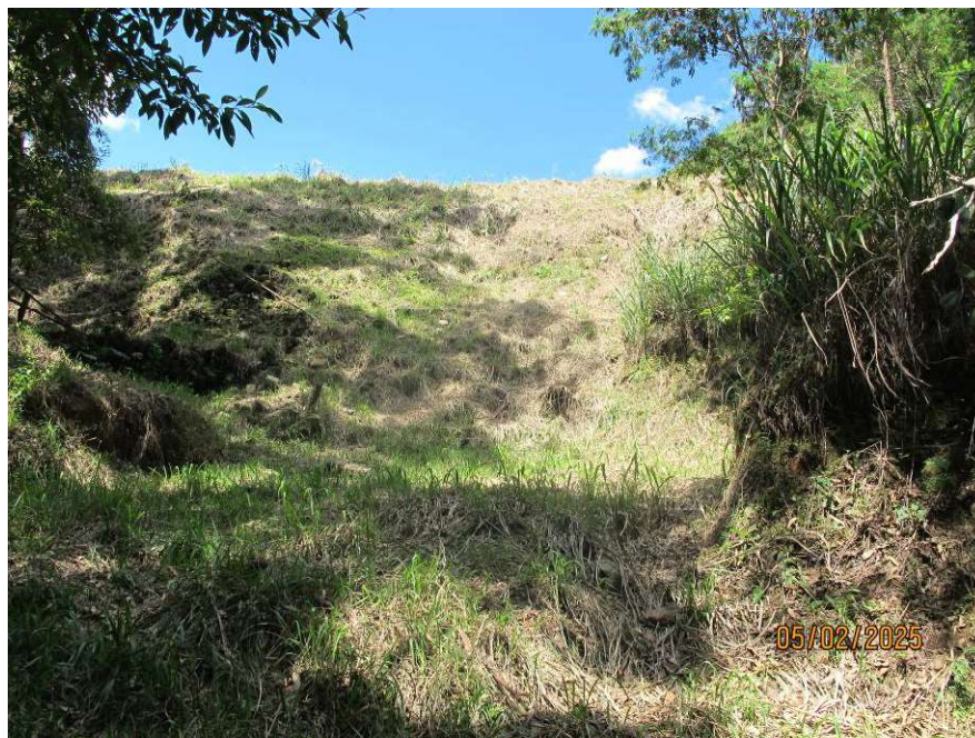
Figura 5.20- Vista do barramento a partir da região jusante – Fev/25.
