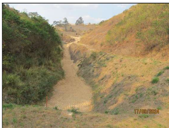
4.14- Registro de 17/09/2024 – Reservatório completamente “seco”. Altura da lâmina d’água – h = 0 cm / Percentual de assoreamento do reservatório: 0,00 %.
