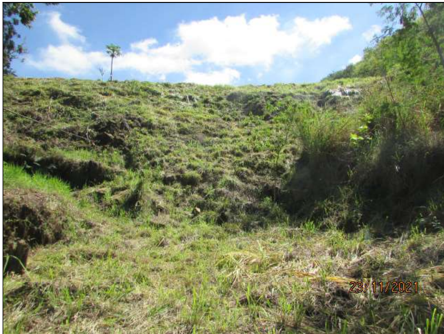
Figura 5.15- Vista do barramento a partir da região jusante – Nov/21.
