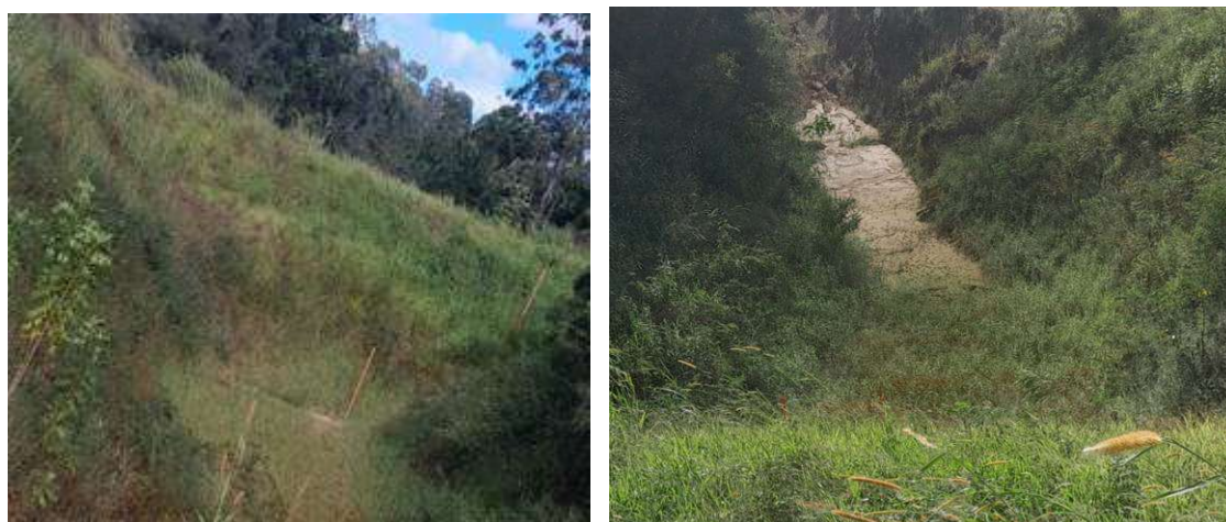
Figura 4.10- Registro de 21/05/24 – Reservatório completamente “seco”. - Altura da lâmina d'água – h = 0 cm / Percentual de assoreamento do reservatório: 1,25 %.
