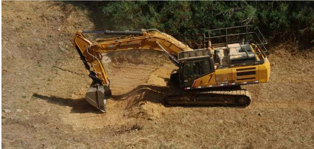
Figura 4.2- Operação de desassoreamento do dique D-03 – Ago/24.
