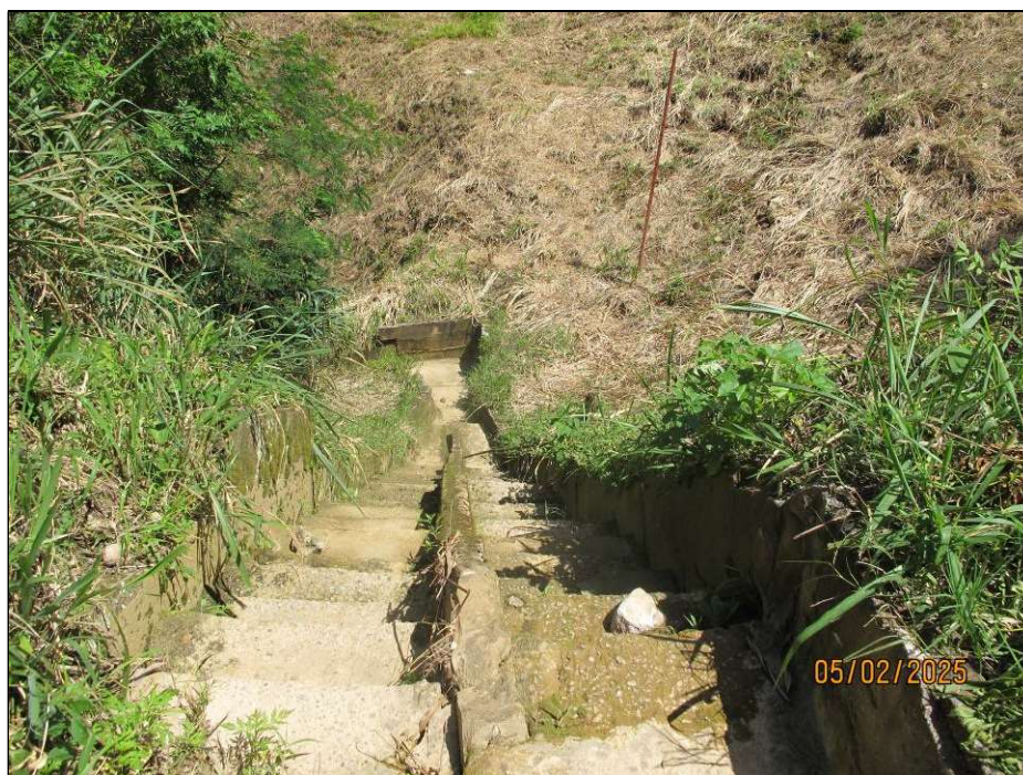
Figura 5.3- Vista da escada de transferência de fluxo para o interior do reservatório, a partir do ponto de desemboque do sistema de drenagem superficial.
