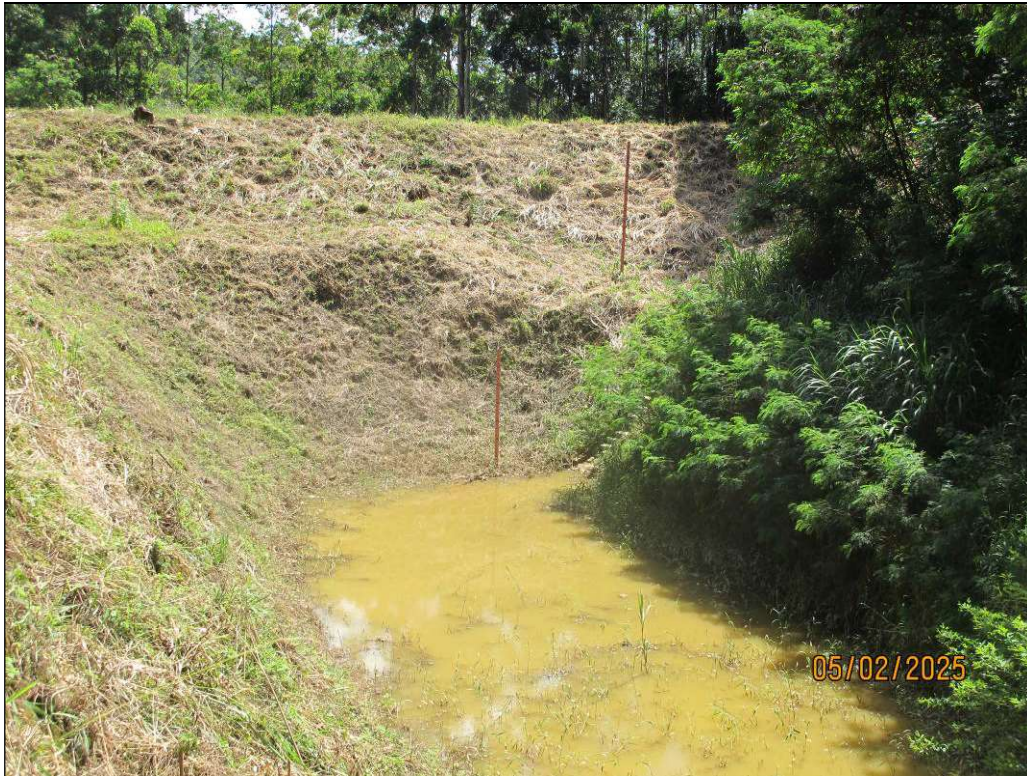
Figura 5.12- Talude de montante – Ausência de anomalias.
