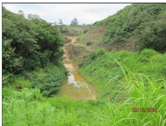
4.17- Registro de 03/12/2024– Reservatório úmido, com uma pequena poça acumulada no interior, porém sem alcançar a régua e o talude de montante. Altura da lâmina d’água – h = 0 cm / Percentual de assoreamento do reservatório: 0,00%.
