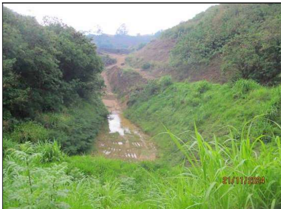
4.16- Registro de 21/11/2024 – Reservatório úmido, com uma pequena poça acumulada no interior. Altura da lâmina d’água – h = 0 cm / Percentual de assoreamento do reservatório: 0,00%.
