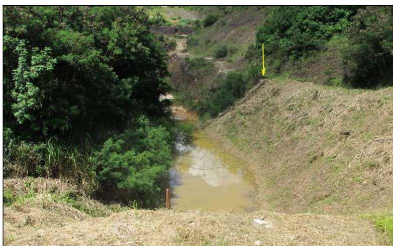
Figura 5.9- Escada de transferência localizada próxima à ombreira esquerda.
