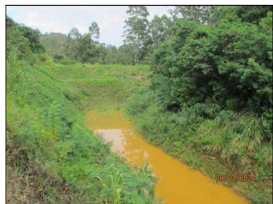
Figura 4.8- Registro de 06/03/24 – Pequena lâmina de água acumulada no fundo do reservatório - Altura da lâmina d'água – h = 5 cm / Percentual de assoreamento do reservatório: 0,80%.
