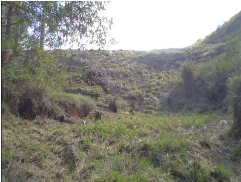
Figura 5.13- Vista do barramento a partir da região jusante – Nov/19.
