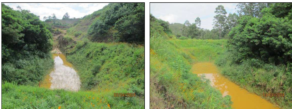
Figura 4.9- Registro de 03/04/24 – Pequena lâmina de água acumulada no fundo do reservatório - Altura da lâmina d'água – h = 5 cm / Percentual de assoreamento do reservatório: 1,25 %.
