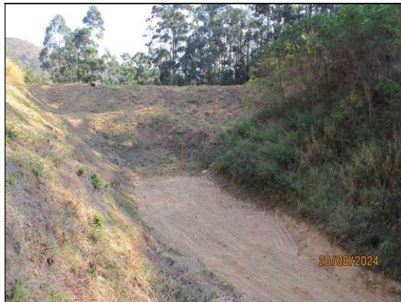
4.13- Registro de 20/08/2024 – Reservatório do dique D-03 após a operação de desassoreamento. Completamente “seco”. Altura da lâmina d’água – h = 0 cm / Percentual de assoreamento do reservatório: 0,00 %.
