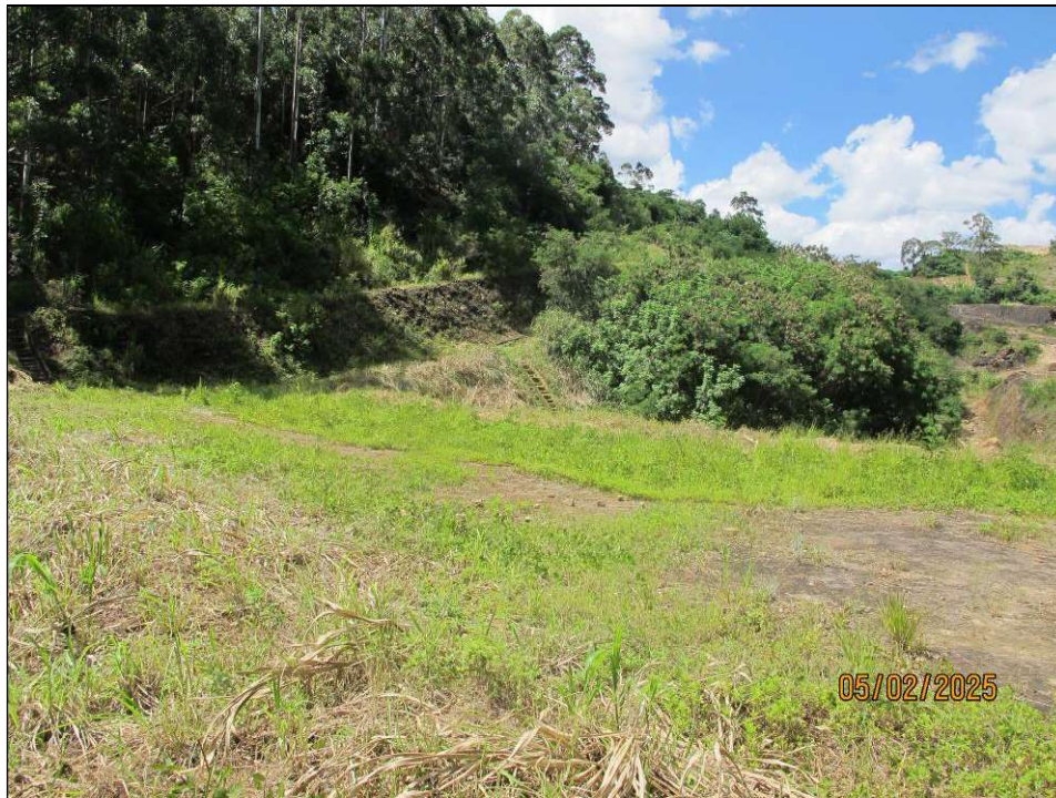
Figura 5.4- Vista da crista do barramento e da ombreira direita do dique D-03
