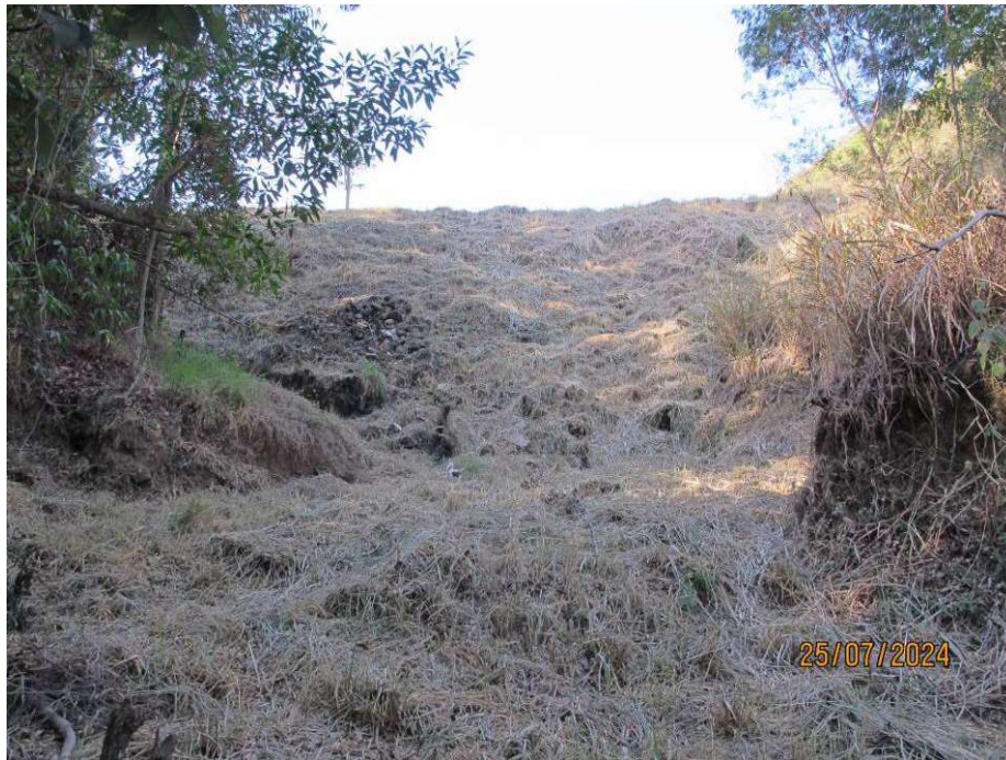
Figura 5.19- Vista do barramento a partir da região jusante – Jul/24.
