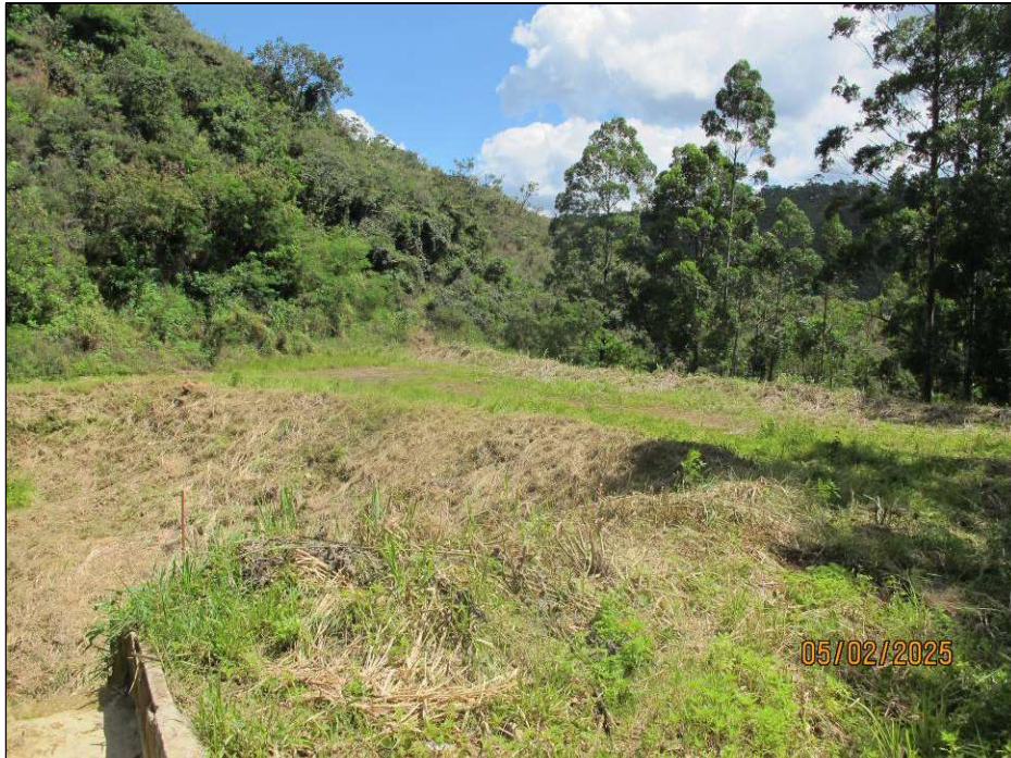
Figura 5.5- Vista da crista do barramento e da ombreira esquerda do dique D-03.
