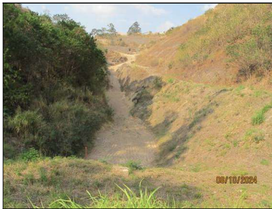
4.15- Registro de 08/10/2024 – Reservatório completamente “seco”. Altura da lâmina d’água – h = 0 cm / Percentual de assoreamento do reservatório: 0,00 %.
