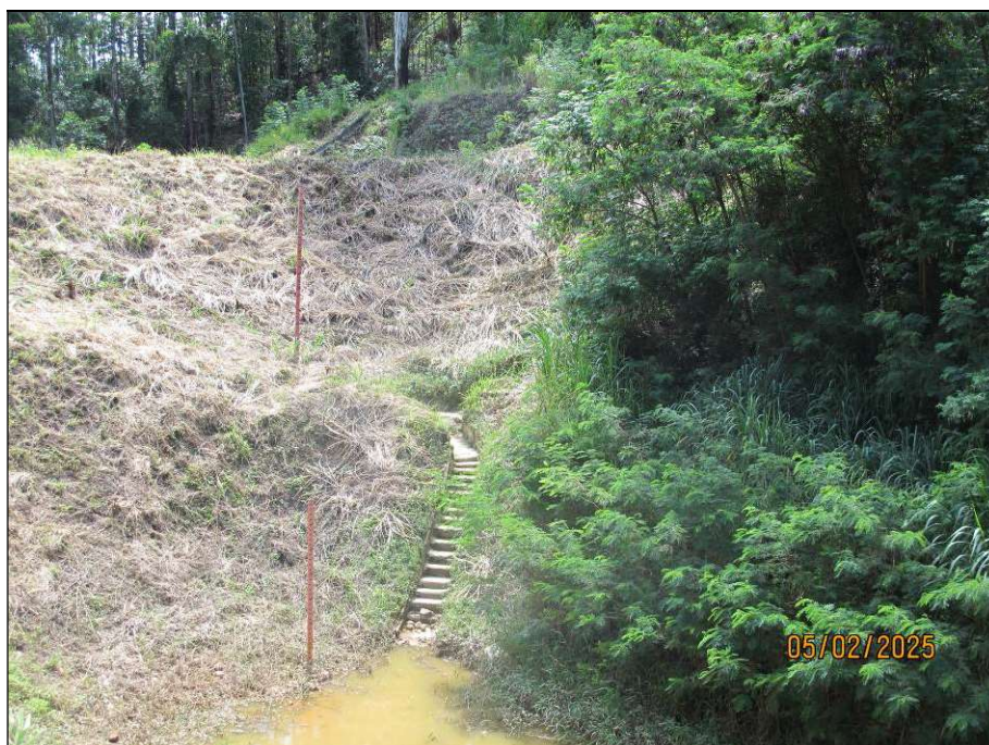
Figura 5.7- Vista do ponto de desemboque da escada de transferência localizada próxima à ombreira direita.
