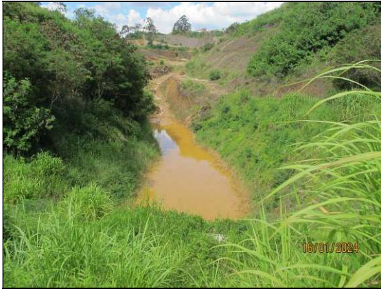
4.6- Registro de 16/01/24 – Pequena lâmina de água acumulada no fundo do reservatório - Altura da lâmina d'água – h = 5 cm / Percentual de assoreamento do reservatório: 0,00%.
