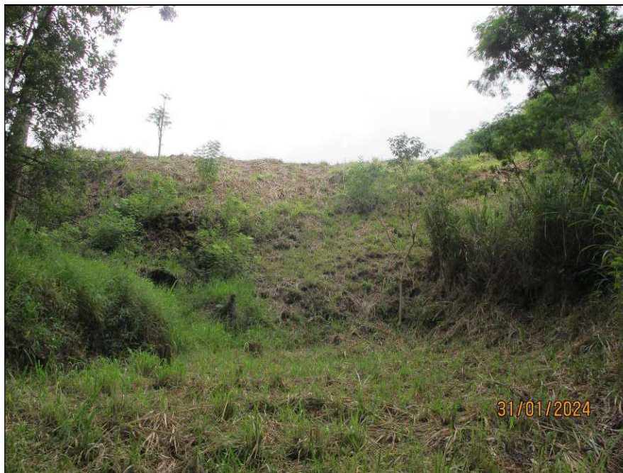
Figura 5.18- Vista do barramento a partir da região jusante – Jan/24.
