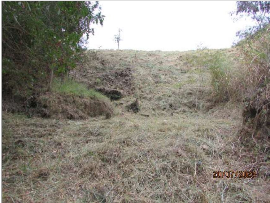
Figura 5.17- Vista do barramento a partir da região jusante – Jul/23.
