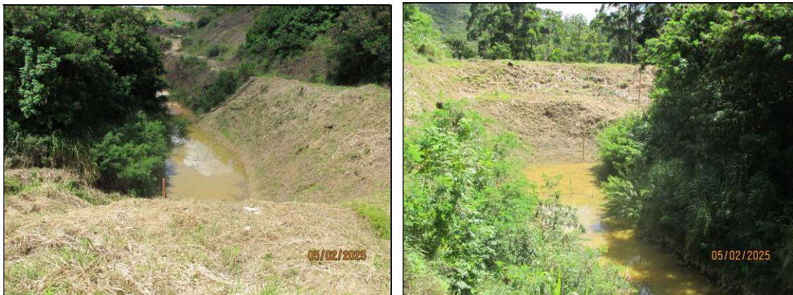
Figura 5.11- Vista do talude de montante e reservatório do dique D-03 – 05/02/2025.
