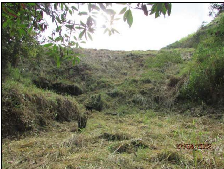
Figura 5.16- Vista do barramento a partir da região jusante – Abr/22.
