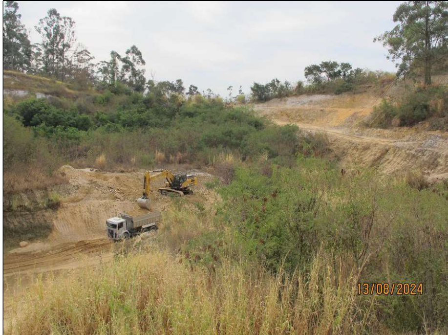
Figura 4.1- Operação de desassoreamento da bacia de decantação auxiliar – Ago/24.
