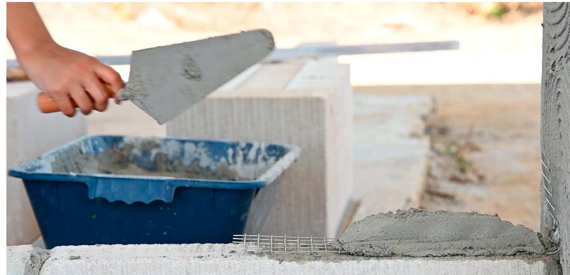
Vinculação da alvenaria ao pilar de concreto
