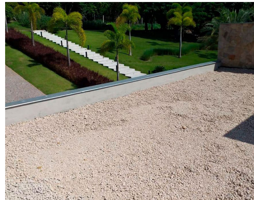
Laje com proteção
