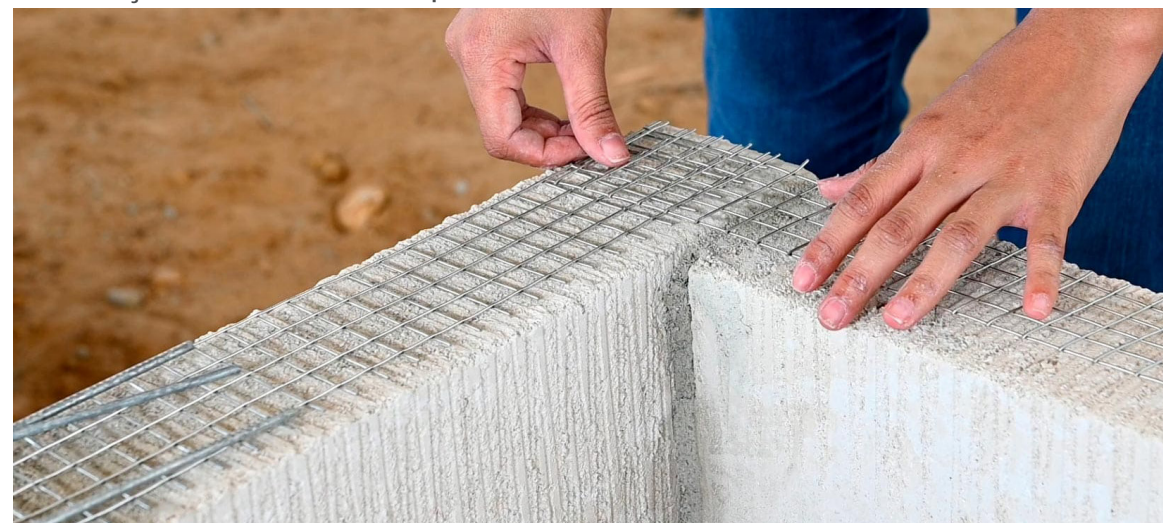
Estruturação de amarrações da alvenaria
