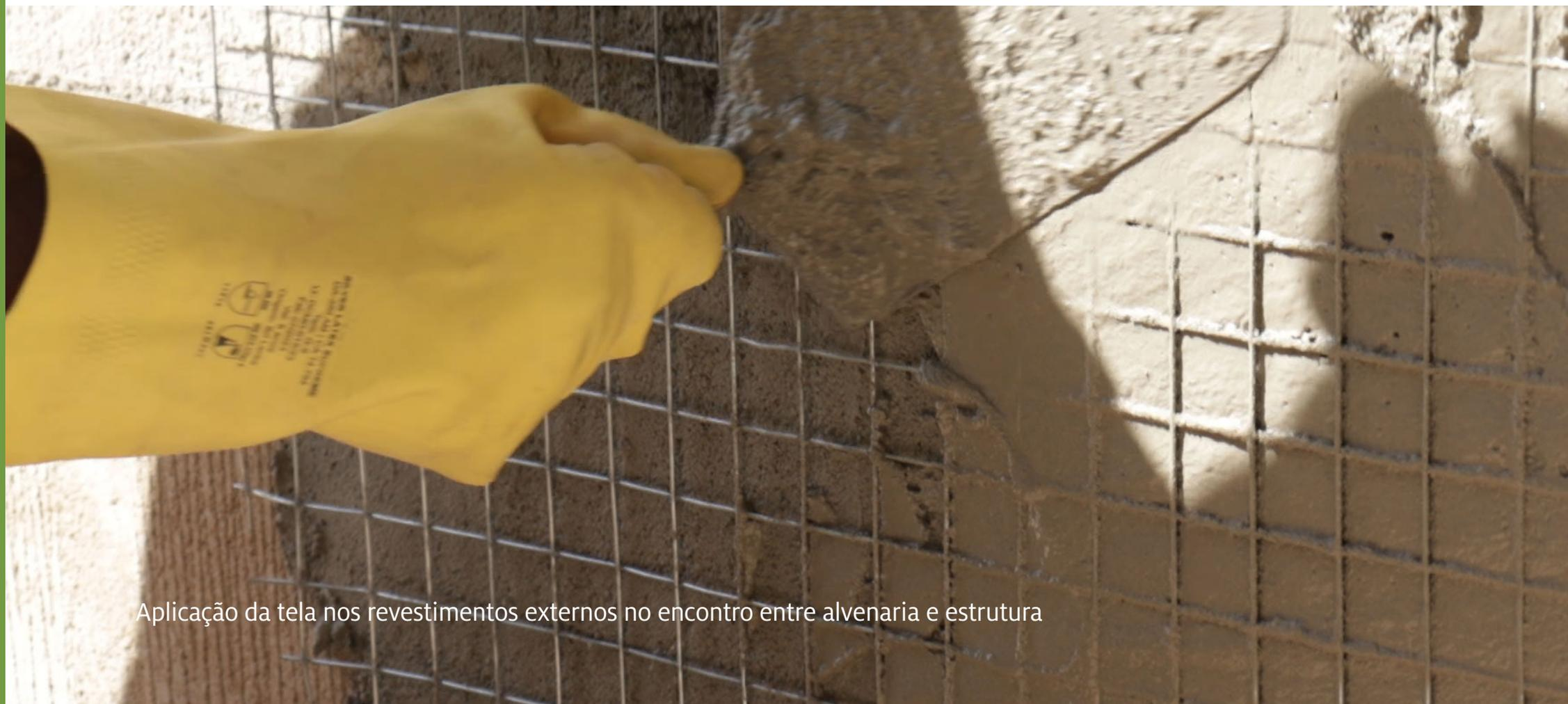
Aplicação da tela nos revestimentos externos no encontro entre alvenaria e estrutura
