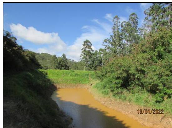
17- Registro de 18/01/2022– Redução do volume de água no reservatório pela infiltração através da formação rochosa.
