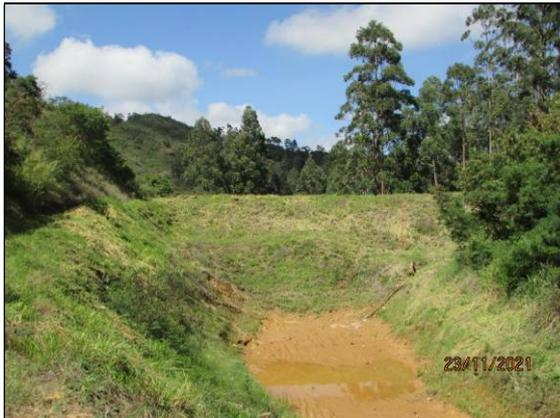
12- Registro de 23/11/2021– Ocorrência de chuvas e infiltração através da formação rochosa com o acúmulo de pequeno volume de água e sedimentos no interior do reservatório.
