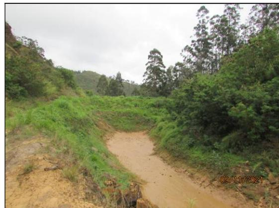
10- Registro de 09/11/2021– Ocorrência de chuvas e infiltração através da formação rochosa com o acúmulo de sedimentos no interior do reservatório.
